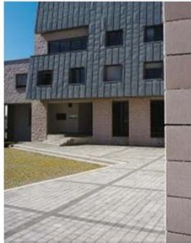
Accès de la caserne de pompiers, Colmar
