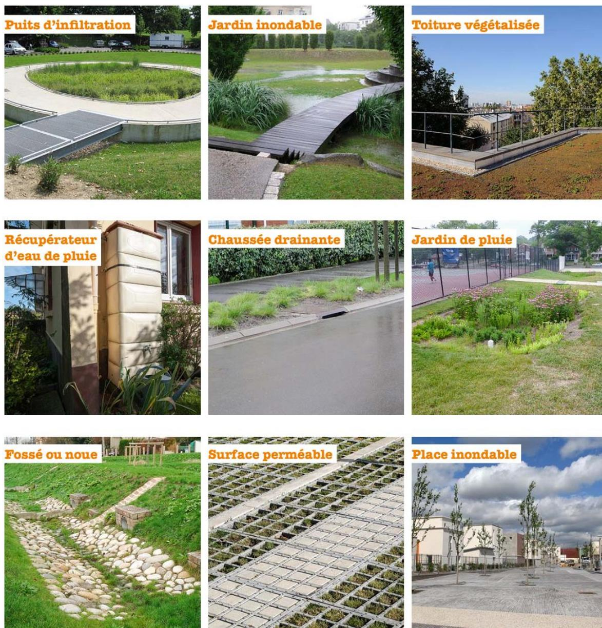
Figure 1.5 - Représentation des principales techniques alternatives (Ministère de l'écologie, du développement durable et de l'énergie, 2013)
