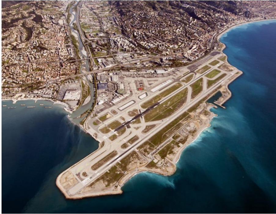
Figure 1-4 : Terre plein ayant permis la construction de l'aéroport de Nice (Batirama, 2018)
