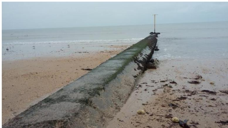
Figure 1-5 : Illustration d'un brise lame à Luc-sur-Mer (Calvados, France)
