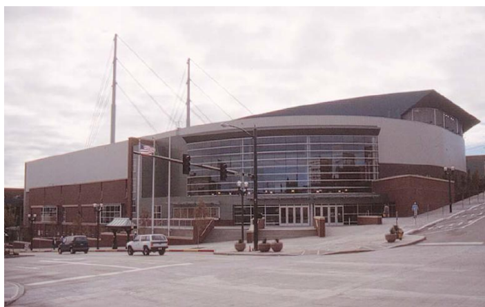
Figure 95. Un exemple de complexe sportif pouvant servir en tant que structure d'évacuation verticale en accueillant un grand nombre de personnes. Source : (FEMA, 2009a).
