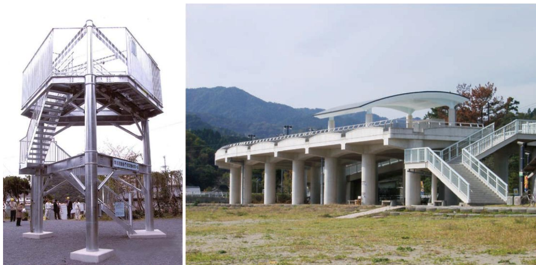
Figure 94. Structure qui a été développée pour être une option d'évacuation verticale simple au Japon (à gauche) et structure d'évacuation verticale à Shirahama Beach Resort (Japon) conçue pour accueillir plus de personnes (à droite). Source : (FEMA, 2009a)
