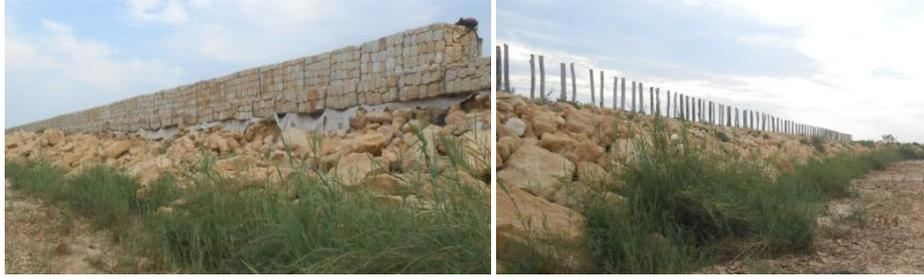
Figure 57. La digue de Fihierenana (intacte à gauche, démantelée à droite) (cliché : Champin, 2016)
