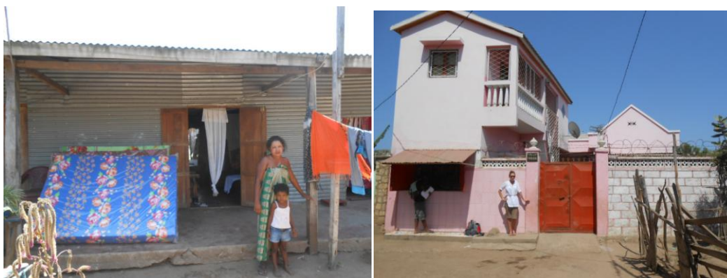
Figure 119. Habitations ayant vécu une hauteur d'eau entre 0 et 1 m.
