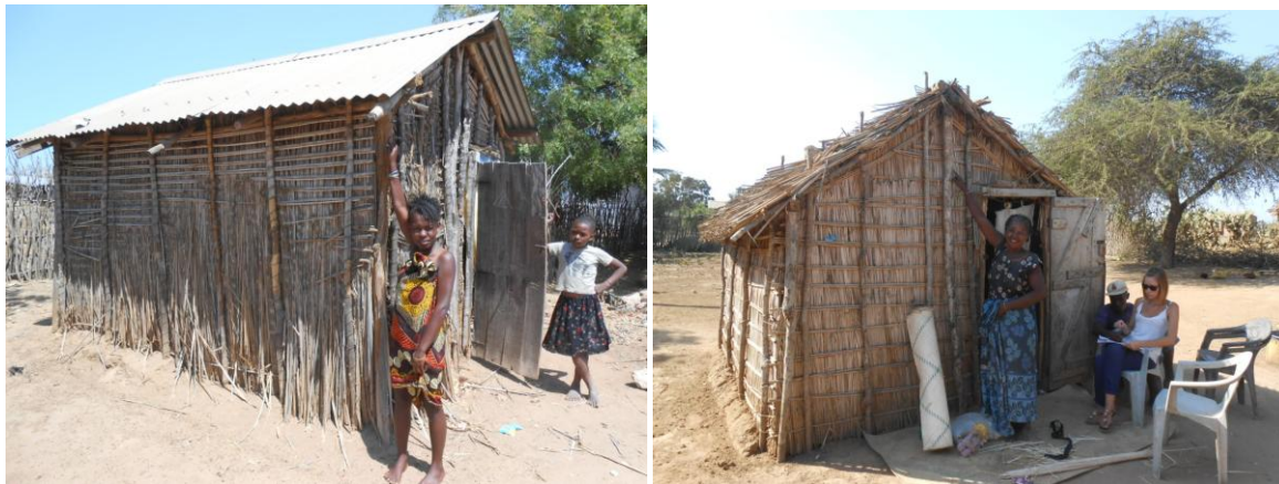
Figure 117. Habitations ayant vécu une hauteur d'eau supérieure à 2 m (seuil critique)
