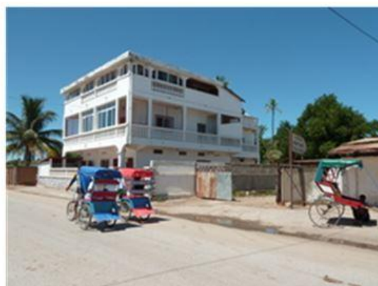
Maison disposant d'un étage (1pt)
