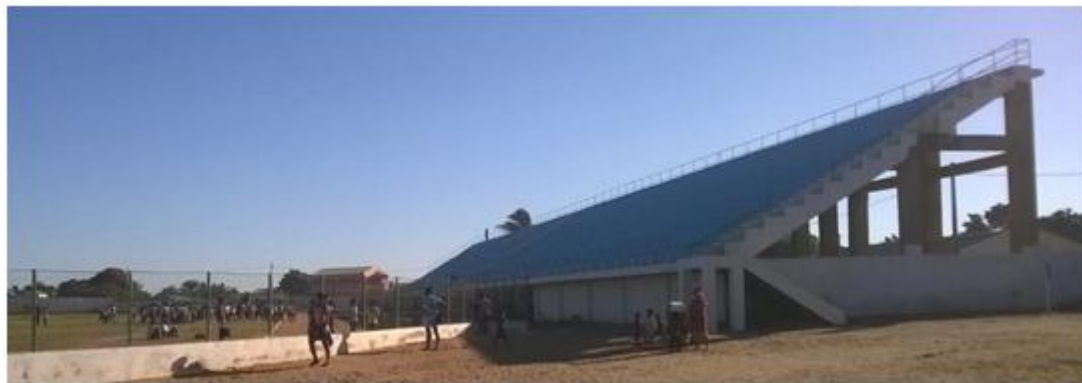
Figure 96. Le stade de foot « Maître Kira » à Toliara qui sert de zone de refuge grâce à ses hauts gradins. Cliché : Champin. (2015).
