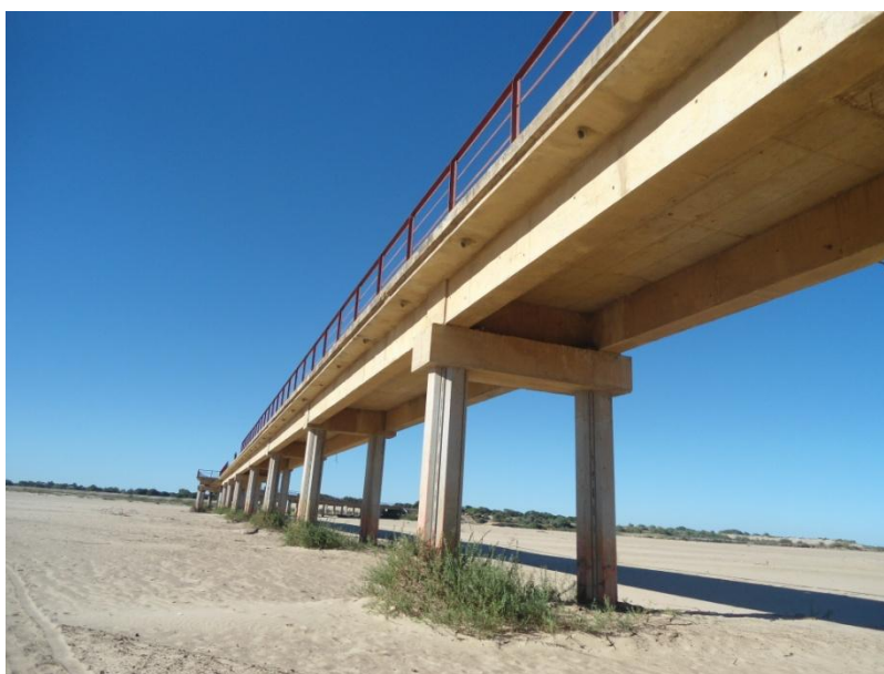
Figure 51. Le pont de Belalanda en période d'étiage (cliché : Rakotoarisoa 2015).
