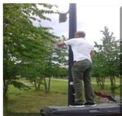
Figure M : Installation d'un transmetteur
