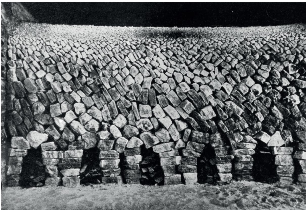
Fig.35. Un four à plâtre avant l'allumage à Noisy-le-Sec, 1925, Photo Auguste Robin, in *La Terre*, Larousse, 1925. Source : Musée du Plâtre.
