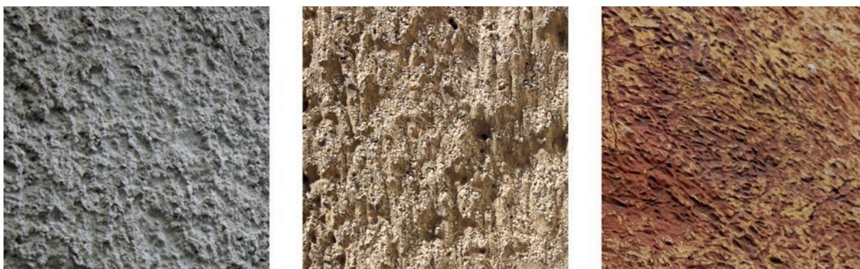
Fig.67. Crépis apparents sur les façades du Moulin des Clayes à Saint-Rémy-lès-Chevreuses (78), du 22 rue Geoffroy Lasnier à Paris (75), d'une maison à Théméricourt (95). Le premier est un crépi fait avec des grains solides, le troisième est fouetté au balai. La richesse des textures et des couleurs, leur altération par les peintures ou l'érosion rend chaque façade unique. Source : Tiffanie Le Dantec.
