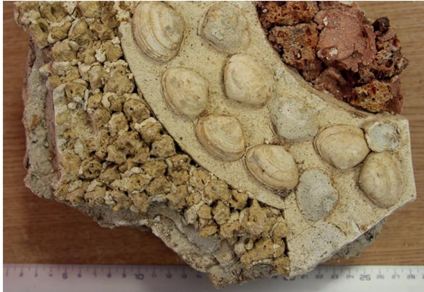
Fig.84. Ornaments de rocaille de la grotte de du Château de Noisy (Bailly, 78). Cette grotte de la fin du XVI<sup>e</sup> siècle et ensevelie, révèle la finesse de la technique qui allie la couleur du plâtre servant de « colle » à celle des éléments de rocaille.
