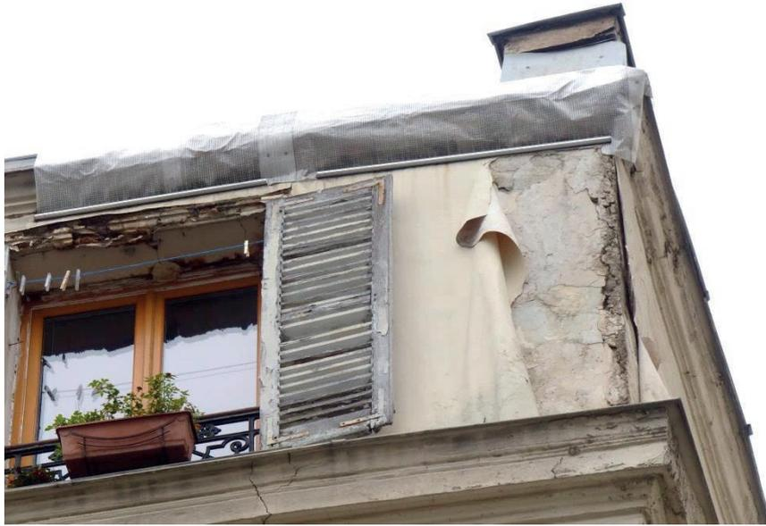
Fig.167. Peinture épaisse (RPE) qui se décolle suite à des infiltrations d'eau dans le mur. Rue Boutebrie à Paris. Source : Tiffany Le Dantec.
