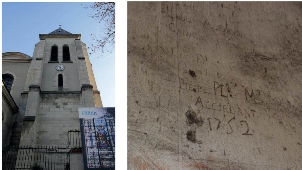
Fig.47. L'intérieur du clocher de l'église de Pantin (à gauche) est enduit de plâtre, dont certains graffitis (à droite) permettent unedatation autour de la deuxième moitié du XVIII<sup>e</sup> siècle. Un prélèvement de l'enduit intérieur révèle des dispositions similaires aux enduits extérieurs relevés en Île-de-France : un crépi d'environ 20mm d'épaisseur, gris et chargé de charbons et de gypse incuits, une couche de finition d'environ 5mm de plâtre tamisé et plus clair.
