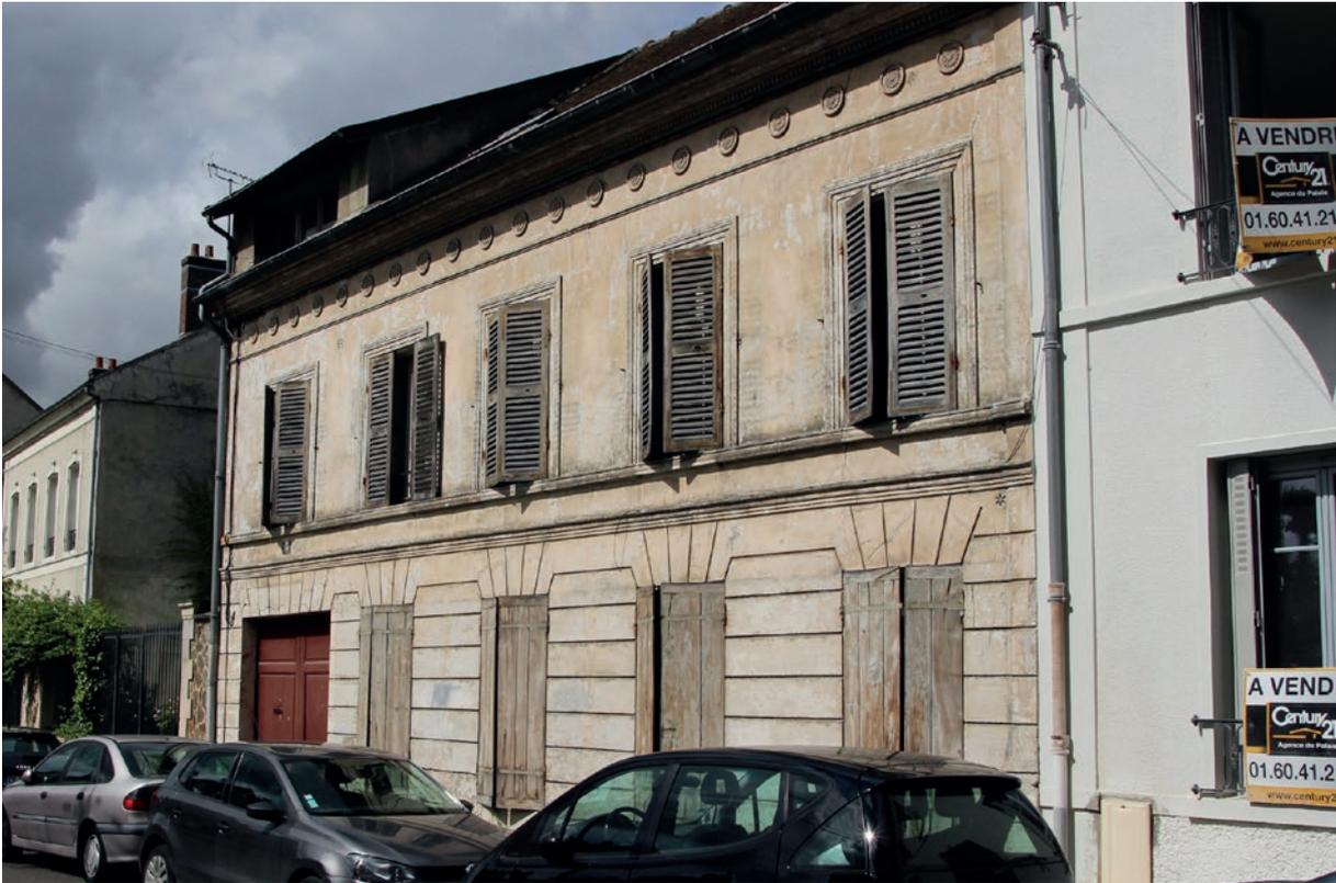
Fig.57. Une simple maison bourgeoise peut présenter une grande variété d'ornements en plâtre. Cette maison, rue de châgée à Meaux (77), présente des corniches et bandeaux, un soubassement à refends tracés dans le plâtre, des encadrements de baie et une frise de motifs fleuris préfabriqués et collés. Source : Tiffany Le Dantec.
