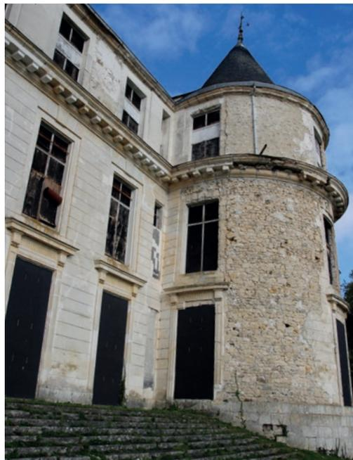
Fig.103. Les gargouilles de fortune du Château de Méréville (91) occasionnent la ruine des ouvrages en plâtre : la sous-face de la corniche et les enduits de la tour sont très dégradés. Source : Tiffany Le Dantec.
