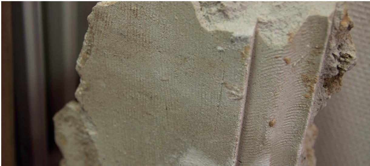
Fig.74. Détail d'un enduit intérieur strié à la gradine, dans la grotte du château des Gonds, 1580-90 (fouilles archéologiques 2017, Bruno Bentz, OMAGE). Source : Tiffanie Le Dantec.
