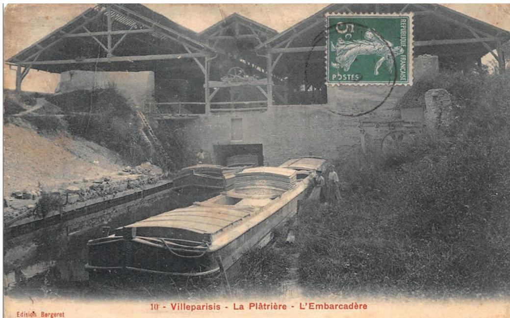
Fig.118. La plâtrière de Villeparisis est habilement construite : le moulin dont tombe le plâtre en poudre est situé au-dessus d'une voie d'eau, ce qui permet de charger directement la péniche. Source : [www.delcampe.net](http://www.delcampe.net)
