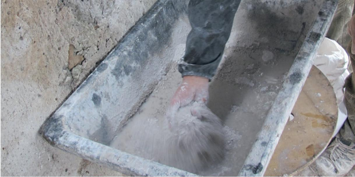
Fig.62. Gâchage manuel du plâtre, dans un volume d'eau le plâtre est saupoudré jusqu'à affleurer à la surface.
