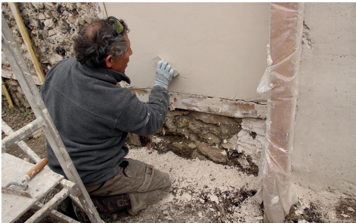
Fig.155. Couper un enduit à la berthelée entraîne une perte de matière et salit le chantier de copeaux de plâtre frais. Source : Philippe Bertone (*Les Ateliers du Paysage*), Tiffany Le Dantec.
