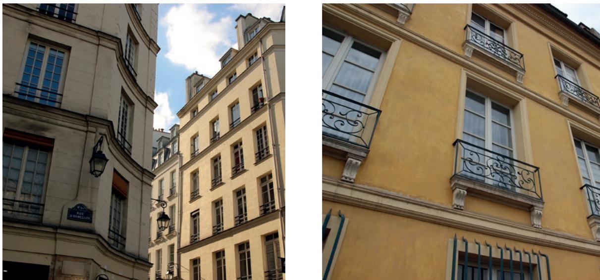
Fig.168. A gauche, édifices parisiens dont des bavettes de zinc recouvrent chaque bandeau, soulignant la façade de lignes noires. A droite, édifice versaillais dont les bandeaux ne sont pas recouverts de bavette, la façade est adoucie. Source : Tiffanie Le Dantec.
