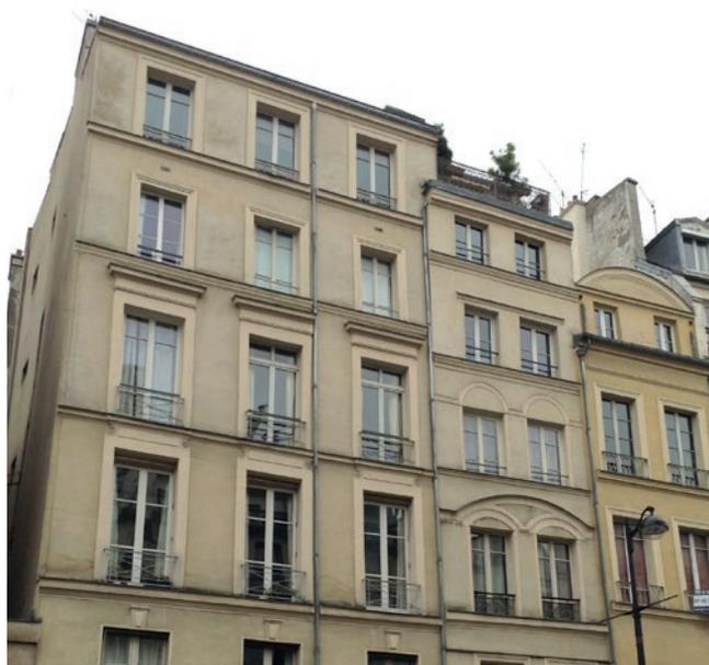
Fig.193. L'attique de cet immeuble rue Saint-Antoine (Paris) ravalé en MPC est soumis à des conditions climatiques plus rigoureuses et l'enduit a d'avantage souffert. Source : Tiffanie Le Dantec.
