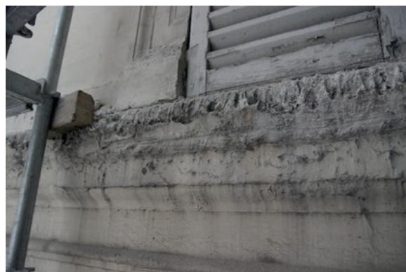
Fig.106. Dans la cour intérieure du 12, rue du Helder (75), datée du milieu du XIX<sup>e</sup> siècle, certaines moulures sont protégées par une bavette de zinc (gauche) et d'autres ont été laissées nues depuis (droite), occasionnant une forte pathologie sur la face du bandeau exposée à la pluie et au ruissellement. Source : Tiffanie le Dantec.
