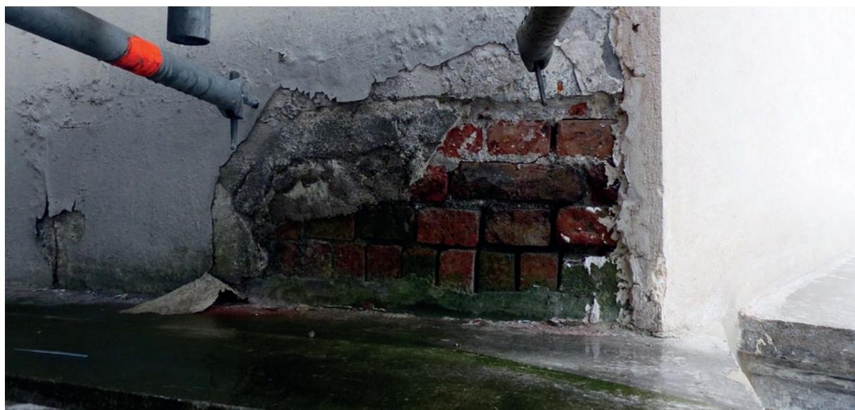
Fig.107. Le pied de l'attique du Théâtre de la Renaissance donne sur un large débord propice garder l'eau. Cette humidité stagnante a finalement rongé le pied de mur, l'enduit et infiltré la maçonnerie de briques. Source : Tiffanie Le Dantec.
