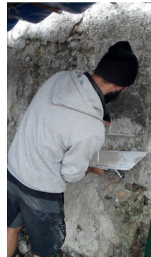
Fig.201. Cuisson des plâtras et mise en oeuvre du produit obtenu, formation sur le site des Murs à Pêches de Montreuil. Source : Tiffanie Le Dantec et Jean Ducasse-Lapeyrusse.
