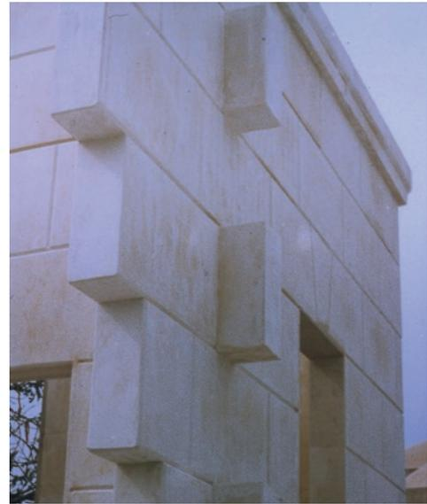
Fig.210. Prototype de l'ouvrage monté à Dakar au Sénégal, en carreaux de plâtre imbriqués. Source : Agence Mauduit & Alluin, Jean-Paul Mauduit.
