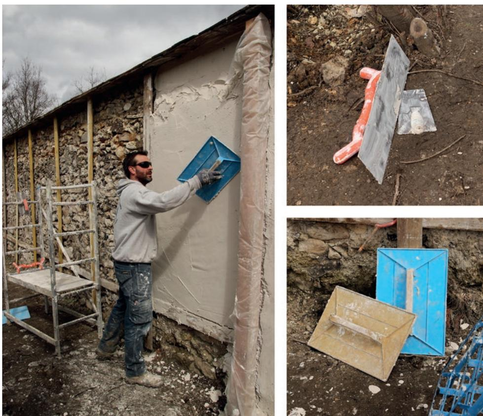
Fig.156. La lisseuse (Haut à droite) et la taloche (Bas à droite) sont des outils relativement récents dans la région parisienne, ils n'étaient pas utilisés dans la mise en oeuvre traditionnelle. Source : Philippe Bertone (*Les Ateliers du Paysage*), Tiffanie Le Dantec.
