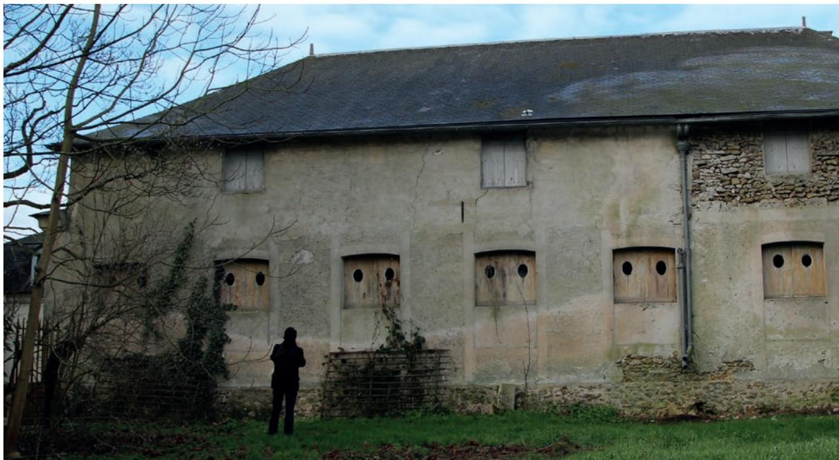
Fig.195. Façade de l'écurie du Château de Jossigny (77). La présence d'animaux et donc d'urine sur le long terme provoque des remontées de sels dans les murs et des enduits, qui sont visibles sur l'image sous la forme du balayage rosé et blanc en peid de mur. Source : Tiffanie Le Dantec.
