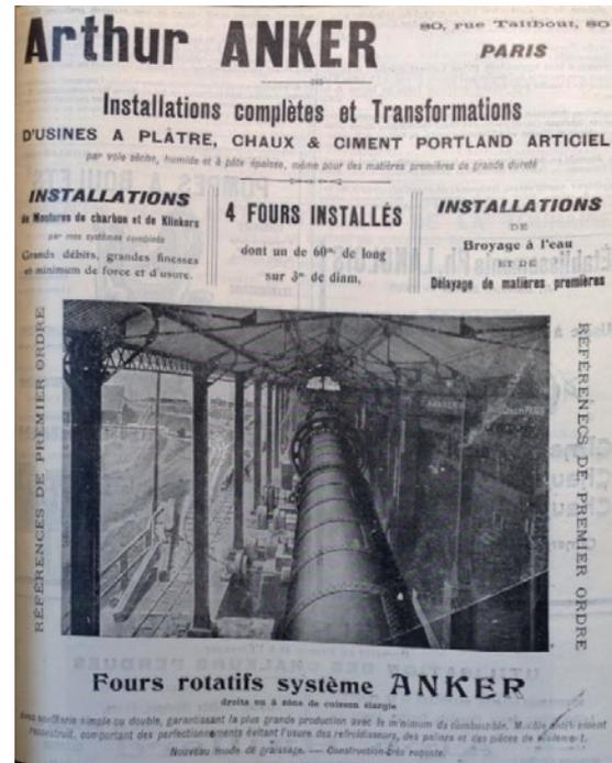
Fig.138. De nombreux fours et broyeurs font partie d'usines tout équipées proposées à la vente au début du XXe siècle. A droite on observe un four rotatif. Sources : (Gauche) *Revue des Matériaux de Construction et de Travaux Publics*, octobre 1911, n° 78, p.5. (Droite) *Revue des Matériaux de Construction et de Travaux Publics*, 1910, n° 68, p.7.
