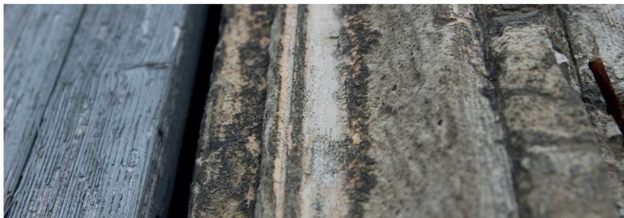
Fig.85. Restes de plusieurs couches de peintures dans une moulure abritée d'un encadrement de baie, Atelier Lorenzi, Arcueil (94). Source : Tiffanie Le Dantec.
