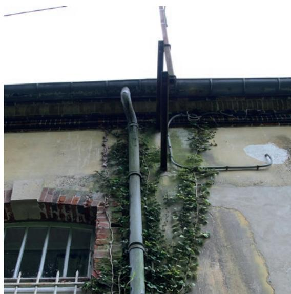
Fig.194. Descentes d'eaux pluviales encastrées ou accolées sur l'enduit. Elles sont des supports de ruissellement, qui est aggravé quand elles se bouchent. Source : Tiffanie Le Dantec.
