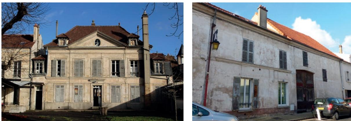
Fig.111. De la riche maison bourgeoise à la ferme, le vocabulaire de la façade en plâtre est présent : soubassement, bandeaux, corniche et murs de cette teinte blanche délavée caractéristique. Source : Tiffanie Le Dantec.
