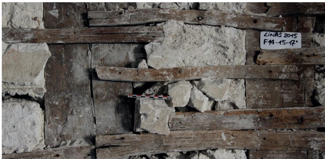
Fig.90. Une cloison en pans de bois hourdés de plâtras recouverts d'un lattis de bois sur lequel était mis en oeuvre un enduit de plâtre aujourd'hui lacunaire. Maison de la fin du XVI<sup>e</sup> siècle, Linas (91) (MLI). Source : Tiffanie Le Dantec.
