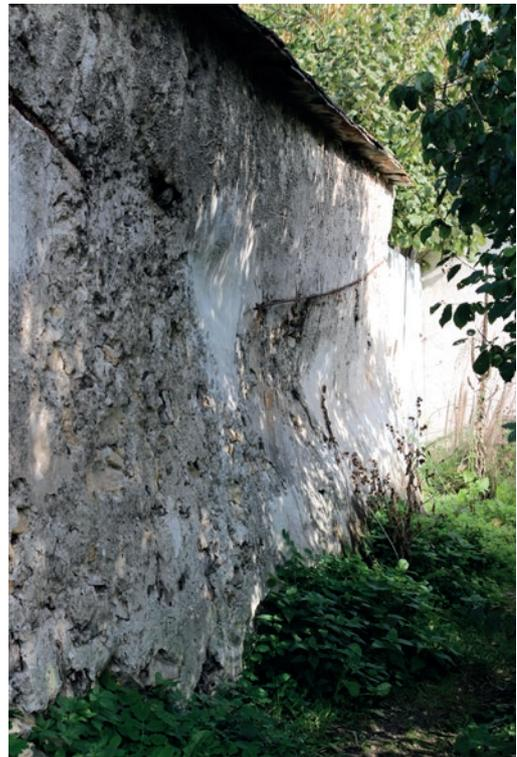
Fig.205. La déformation du plâtre est due au phénomène du fluage qui permet aux cristaux de gypse de glisser les uns sur les autres en présence d'eau. Source : Tiffany Le Dantec.
