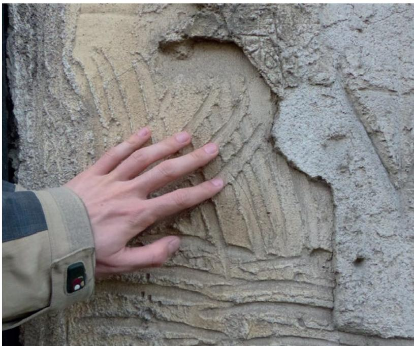
Fig.48. Le décollement de la couche de finition permet de voir le traitement de surface du crépi de cette maison de Goussainville (95). Il a été strié avec les doigts pour assurer l'accroche de la dernière passe. Source : Tiffanie Le Dantec.
