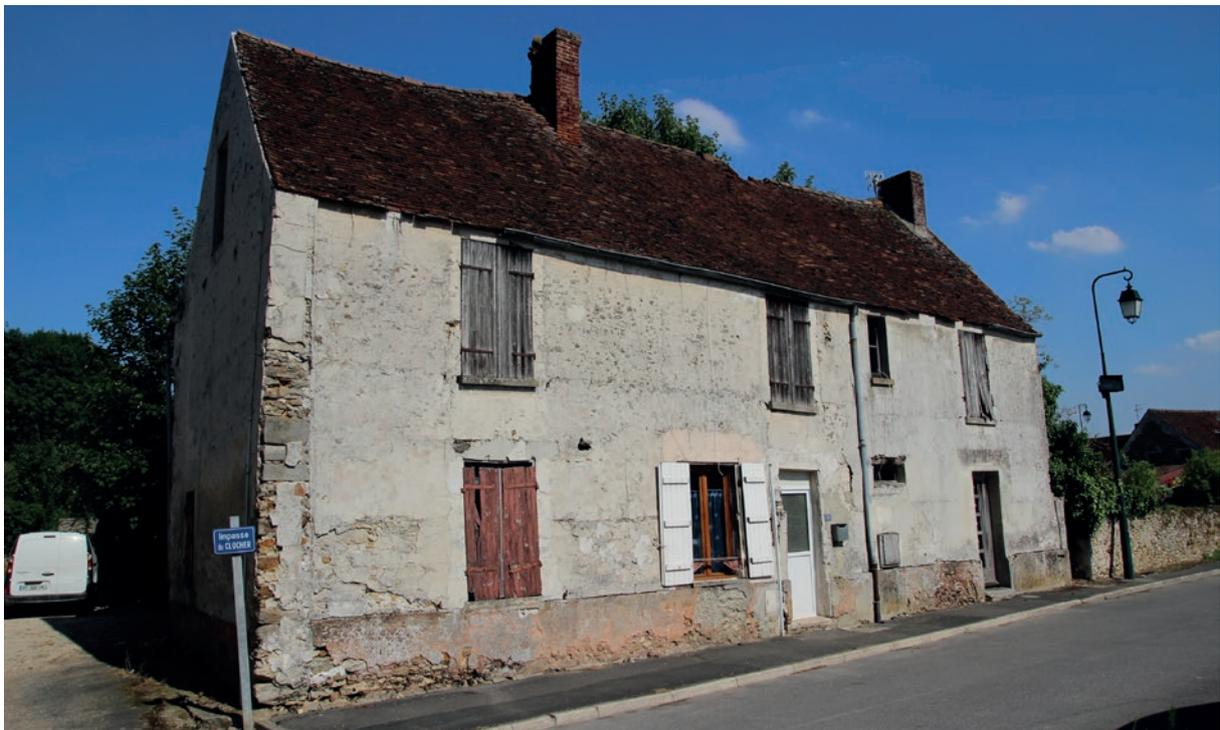
Fig.100. Cette maison, à Marles-en-Brie (77) a un soubassement en mortier romain, dont les tuileaux mêlés à la chaux donne à l'enduit un couleur rose. Ce mélange a été très utilisé au XIX<sup>e</sup> et XX<sup>e</sup> siècle avant l'utilisation plus générale des ciments industriels. Source : Tiffany Le Dantec.
