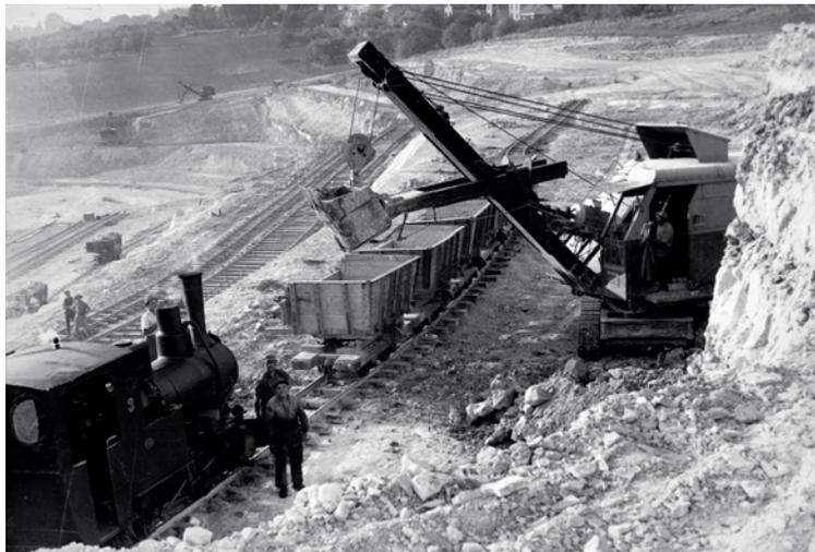
Fig.119. L'élévateur à godets servaient à dégager les marnes situées sur les masses de gypse. Les matériaux étaient ensuite transportés par n train interne à la carrière. Source : Carrière de Cormeilles-en-Parisis, années 1940, collection Musée du Plâtre.
