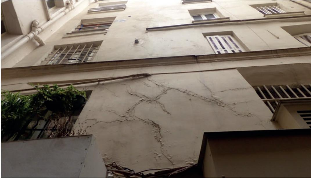
Fig.178. RPE fissuré et rebouché sur un enduit plâtre. Passage Saint-Foy, quartier du Sentier, Paris. Source : Tiffanie Le Dantec.
