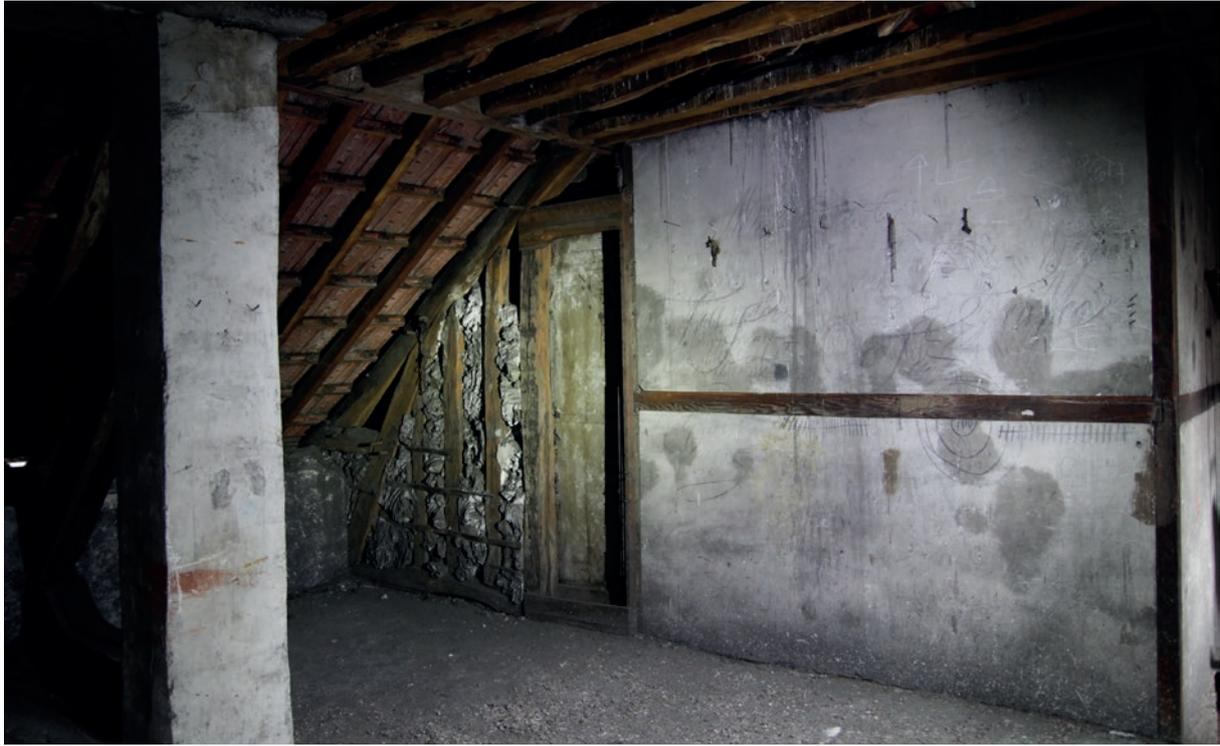
Fig.88. Grenier du 15, rue de la Pierre Levée à Paris. Cet espace est resté intouché depuis la fin du XIX<sup>e</sup> siècle et témoigne des usages du plâtre dans la construction : fumiserie, cloisons, hourdis, enduits, maçonnerie etc. Source : Tiffany Le Dantec.
