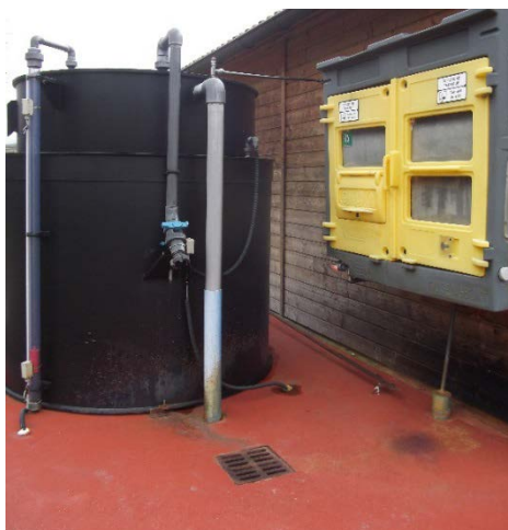
[Figure II.4] Exemple de cuve à chlorure ferrique sur une station de FPR
