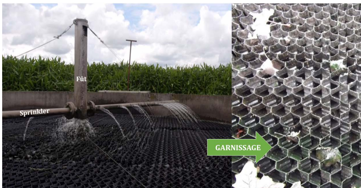
[Figure II.3] Lit bactérien de la station Vercia et zoom sur le garnissage du lit bactérien
