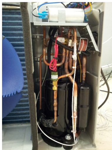
Figure 0-16. Pose de sondes de pression et température autour du compresseur
