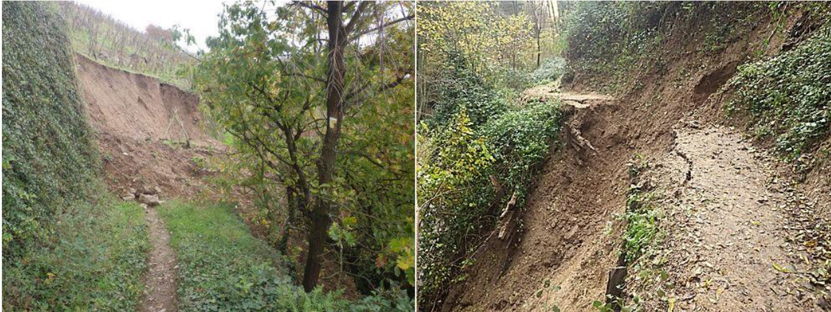
Figure 82 - Talus effondré sur un chemin sous une parcelle de vigne (photo de gauche) et glissement de terrain suite à de fortes pluies (photo de droite) – Source : S. Tarin, 2013
