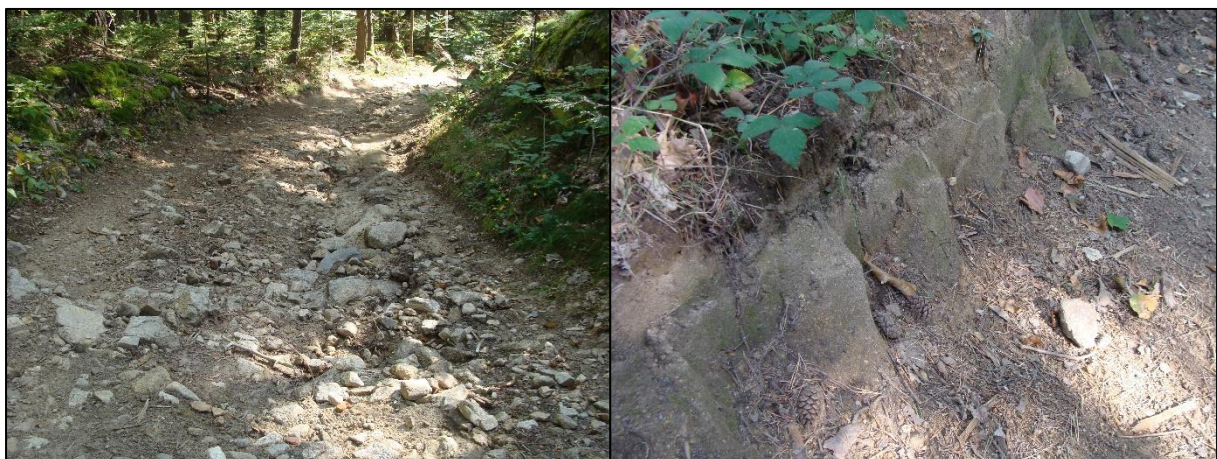
Figure 92 - Illustration de problèmes de dégradations liés au passage de poids lourds motorisés - M. Mery, 2014
