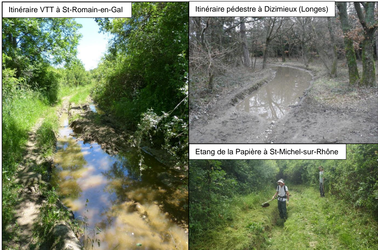
Figure 84 - Photographies de chemins plats sur sol meuble dégradés par des véhicules motorisés
