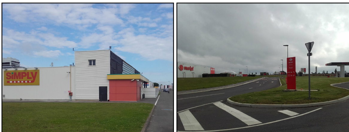
Figure 73 | Supermarché SimplyMarket situé en périphérie de Nesle (80) à gauche et Supermarché Carrefour Market situé en périphérie de Bonneval (28) à droite Photos : Damien Delaville
