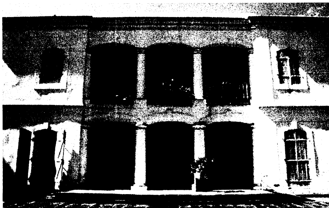
Maison en pierres et briques, au toit plat en argamasse, mêlant les influences occidentales et indiennes.
