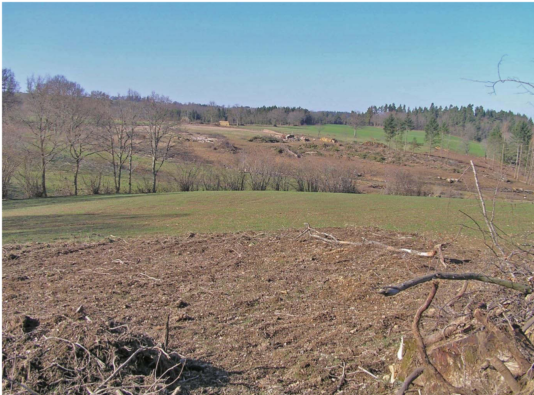
Fig. 19 : Travaux de remembrement dans le secteur de Montléon ; arrachage des haies, abattage d'arbres, reprise des chemins et creusement des ruisseaux (Cliché G. Massounie).
