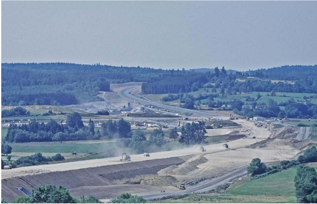
Fig. 18 : Dans la plaine de La Narse, l'impressionnant chantier de construction de l'autoroute A89 qui montre bien qu'il était difficile de respecter les sites archéologiques (Cliché G. Massounie, mai 2005).
