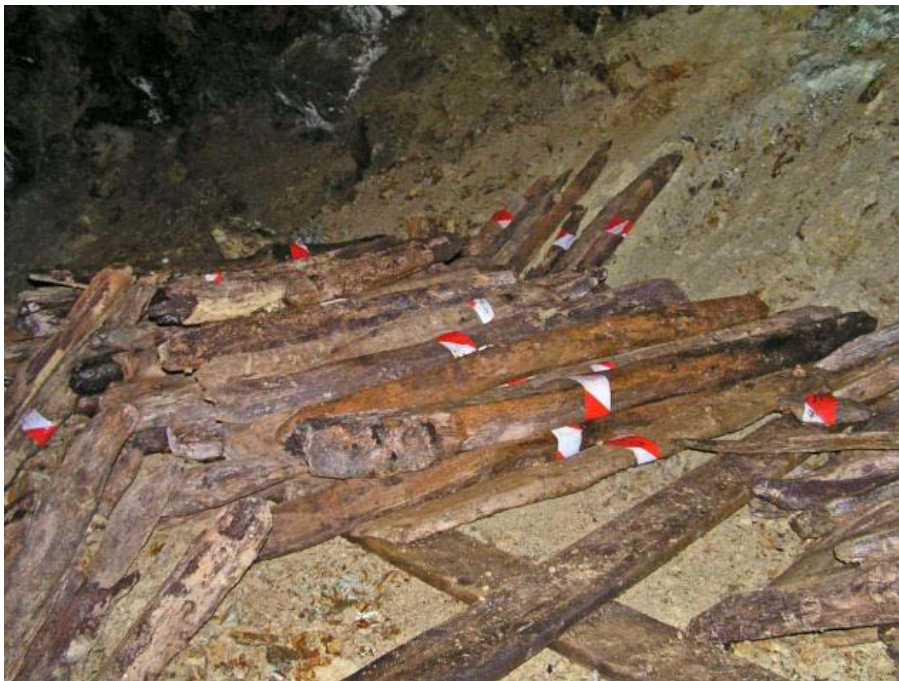
Fig. 49 : La mine des Roziers ; certains bois de la charpente ont été rassemblés pour étudier leur provenance, les techniques de montage, leur datation. Il faut aussi les protéger et assurer leur conservation (Marconnet 2003). (Cliché G. Massounie).
