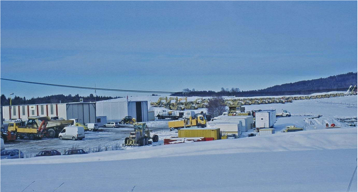
Fig. 14 : Le chantier de l'A89 paralysé par la neige, en janvier 2004 (Cliché G. Massounie).
