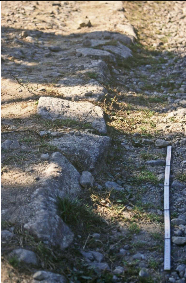
Les pierres de bordure sont déchaussées par le passage du matériel agricole (Cliché G. Massounie).
