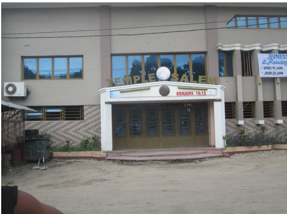
« Temple Salem », situé sur l'avenue By Pass (Commune de Lemba)
