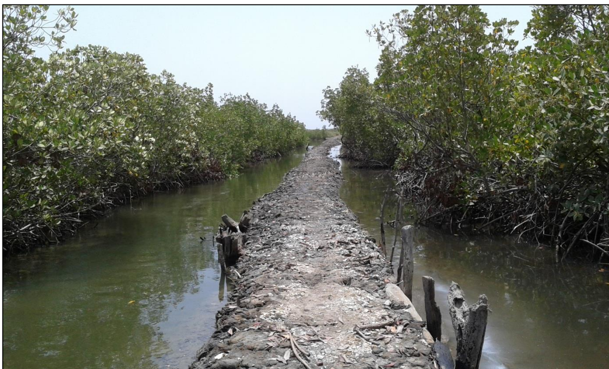
Photo 14: Digue reliant différentes rizières à Thionck-Essyl (mai, 2015)
