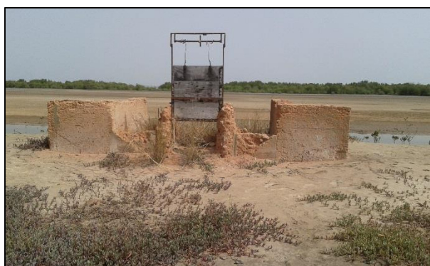
Photo 18 Photo 19: Digue de protection des parcelles rizicoles d'Adéane en état de dégradation avancée (mai, 2015)
