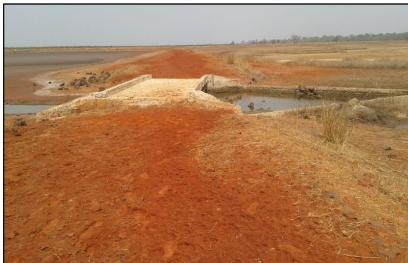
Photo 27: Digue de protection anti-sel de la vallée rizicole de Coubanao (mai, 2015)
