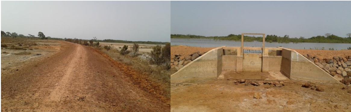
Photo 30 Photo 31: Digue de protection aménagée par le PADERCA dans la vallée rizicole Gnilo de Thionck-Essyl (travaux de terrain mai, 2015)
