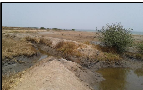
Photo 18 Photo 19: Digue de protection des parcelles rizicoles d'Adéane en état de dégradation avancée (mai, 2015)
