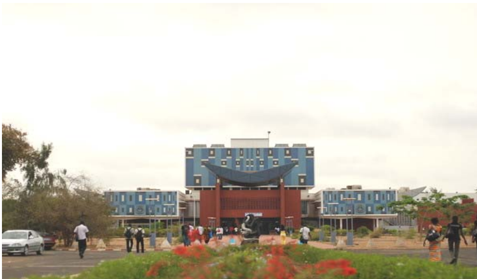
Figure 6 : Bibliothèque centrale de l'université Cheikh Anta Diop de Dakar après sa réhabilitation
