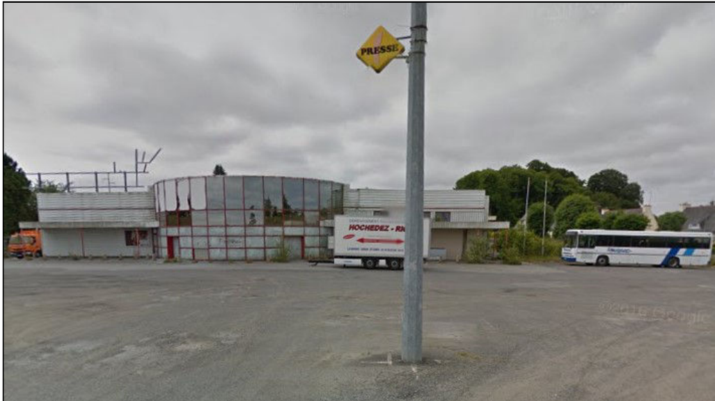
Figure 50 : Ancien supermarché Champion à Saint-Brandan (Source de l'image : Google Street View)
