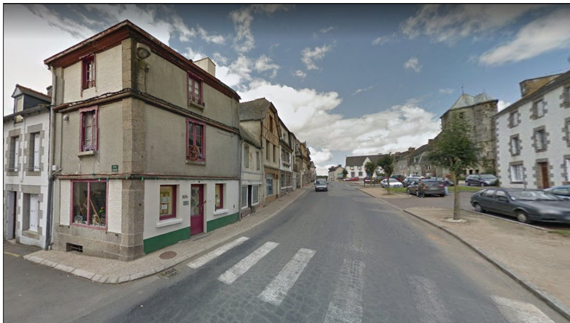
Figure 88b : La même place en 2016, dépourvue de commerces, l'hôtel a été détruit (source de l'image : Google Street View)
