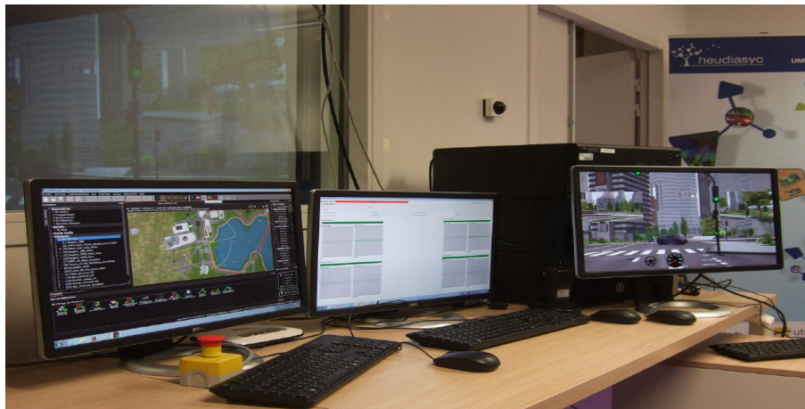
Figure 5.7 – La salle de contrôle
