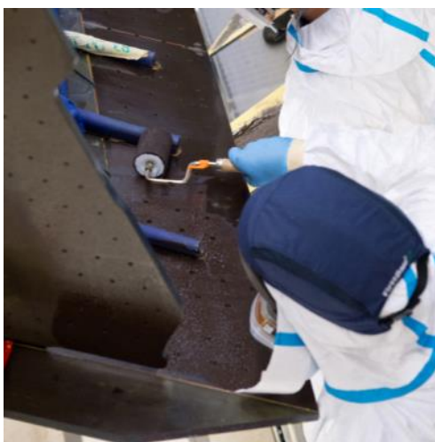
Figure 1.1-4 Pose du mastic d'interposition et des fixations temporaires
