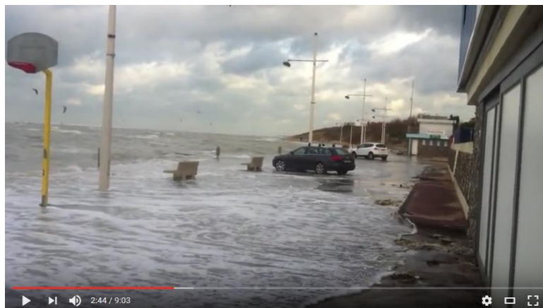
Figure 3-6. Tempête Xaver – digue de Petit-Fort-Philippe
