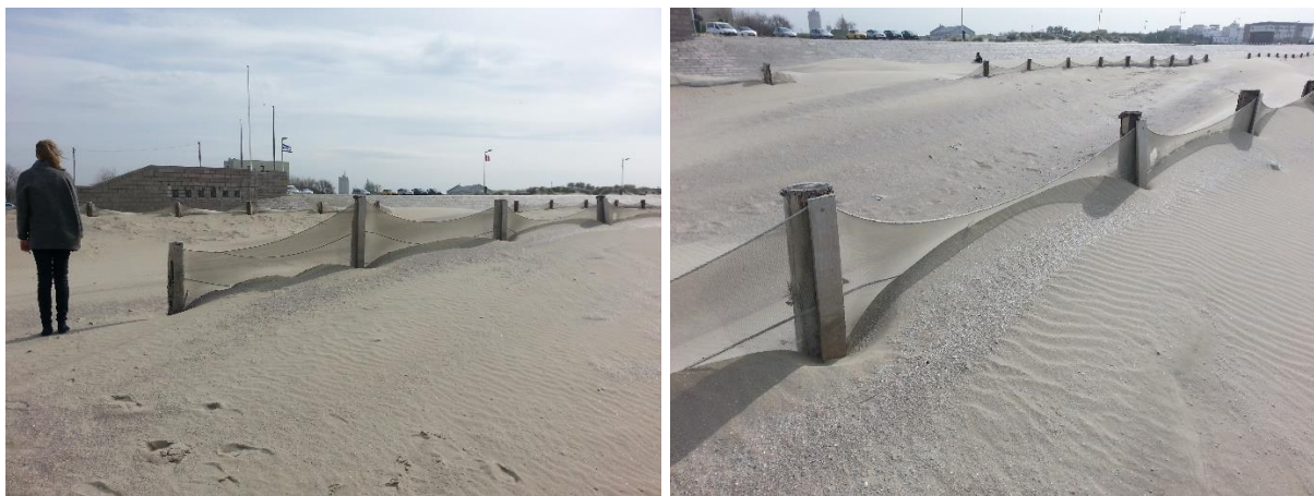
Photographie 3-17. Filets brise-vent sur le site du rechargement en sable de la digue des Alliés
