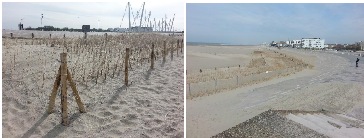
Photographie 3-18. Plantation d'oyats sur le site du rechargement en sable de la digue des Alliés
