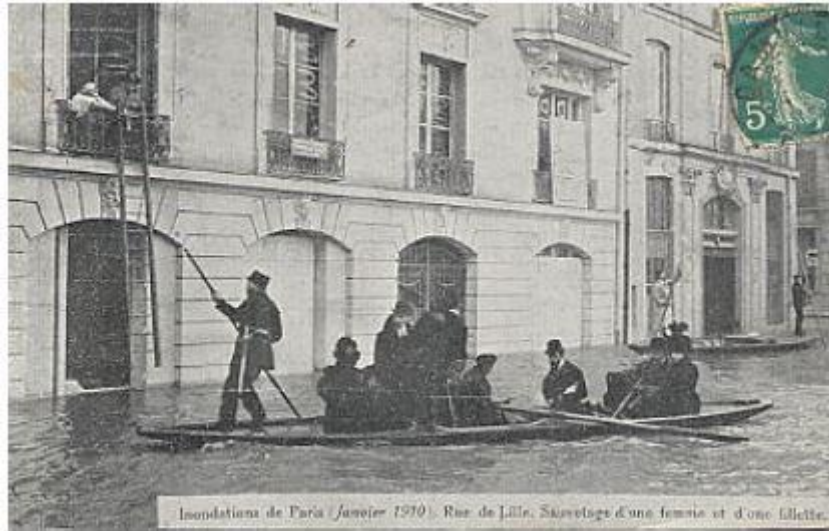
Figure 1-18. Crue de la Seine 1910 – sauvetage rue de Lille – Paris
