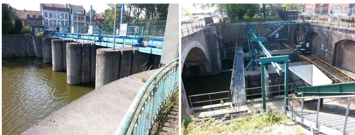
Photographie 3-14. Ouvrage des 4 écluses - Dunkerque
