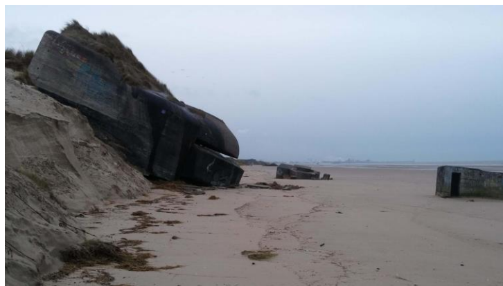
Photographie 3-12. Blockhaus de la plage de Leffrinckoucke – chute suite à la tempête Egon (vue de profil)
