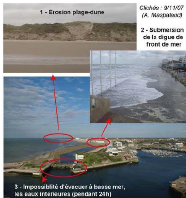
Figure 3-3. Impacts de la tempête de 2007 – impossibilité d'évacuer les eaux intérieures à l'écluse Tixier
