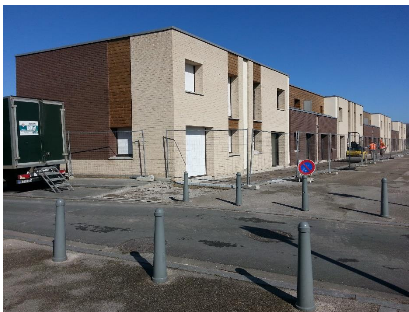
Photographie 4-5. Construction de nouveaux logements au quartier Grand Large
