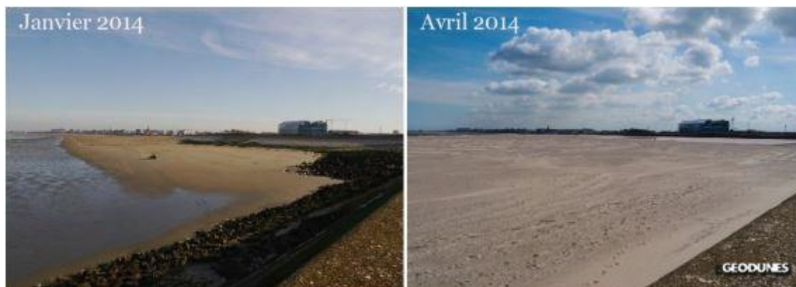
Photographie 3-16. État du site avant et après la seconde phase du rechargement en sable
