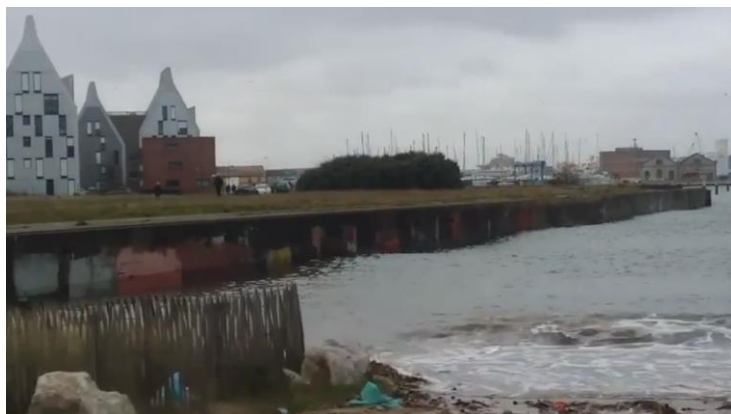
Figure 4-1. Niveau d'eau élevé au niveau de l'ouverture du bassin de plaisance dans le quartier du Grand Large
