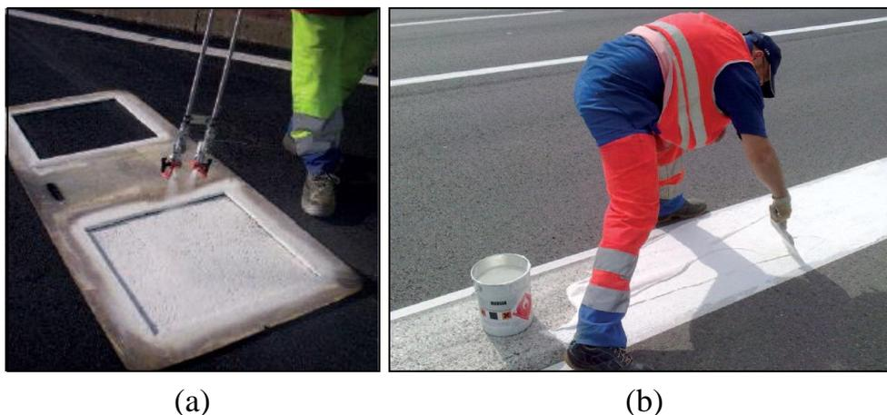
FIGURE 2.9 – Pose manuelle : (a) un cédez-le-passage, (b) une ligne de stop (FÉRÉ 2016)
