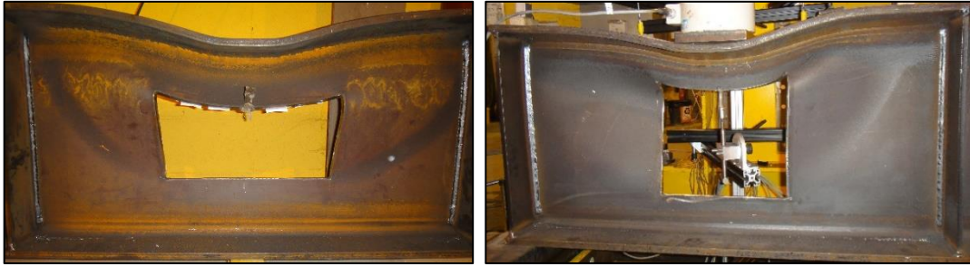
Figure III-10 : Exemples de ruine combinant une flexion élasto-plastique de la membrure supérieure et une instabilité des panneaux d'âme adjacents
