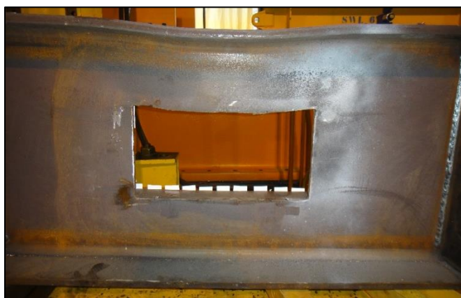
Figure A-8 : A2RHS7 - Illustration du mode de ruine
