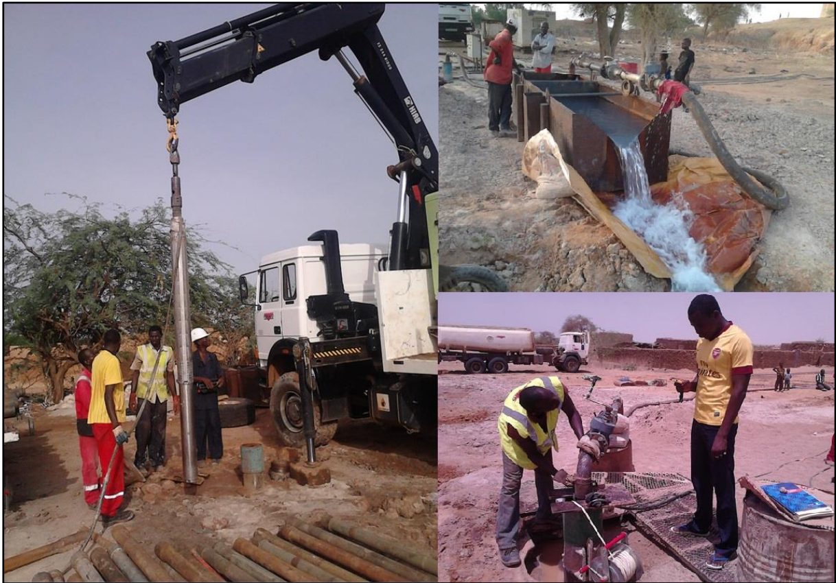
Planche 3 : Opération des essais de pompage dans le Continental Intercalaire/Hamadien
