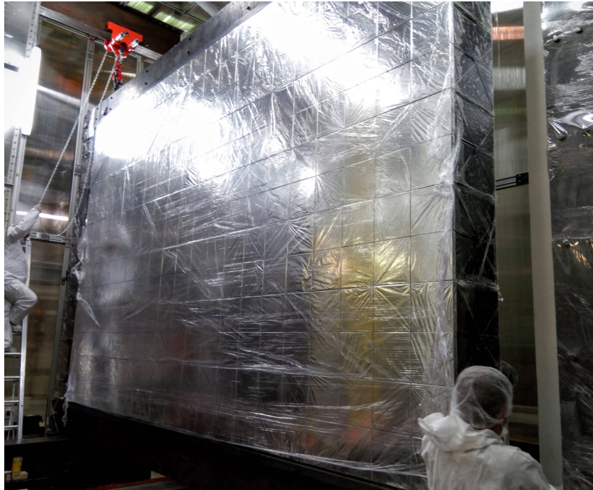
FIGURE 2.6 – Photographie d'un des deux murs du calorimètre du module démonstrateur de SuperNEMO installé au LSM.
