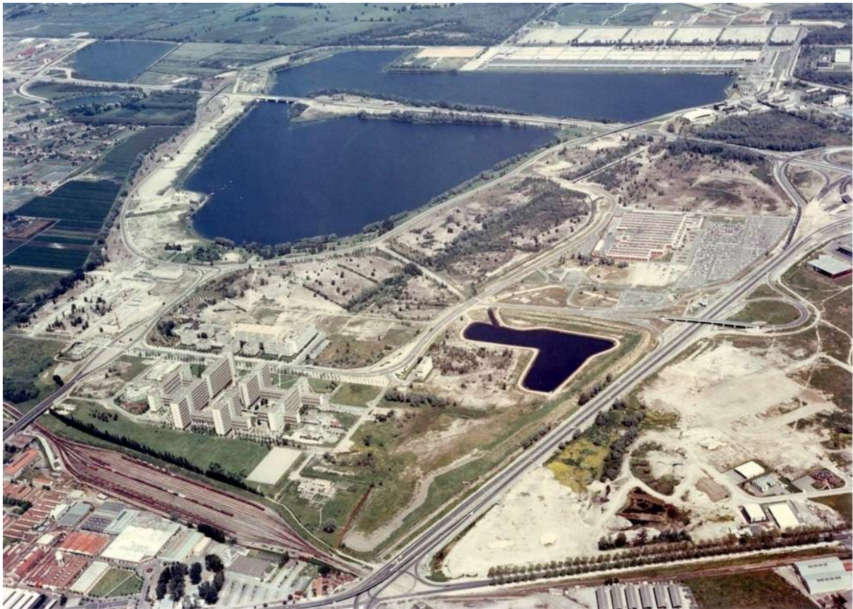
Figure 1.5 – L'opération Bordeaux Lac en 1986 (archives Sud Ouest, 1986)
