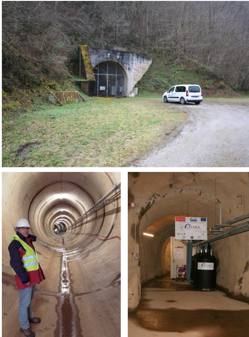
Figure 3.5 : Photos représentant l'entrée du tunnel, et l'intérieur du tunnel (à l'entrée et devant le préfabriqué accueillant les détecteurs à partir de 2016)
