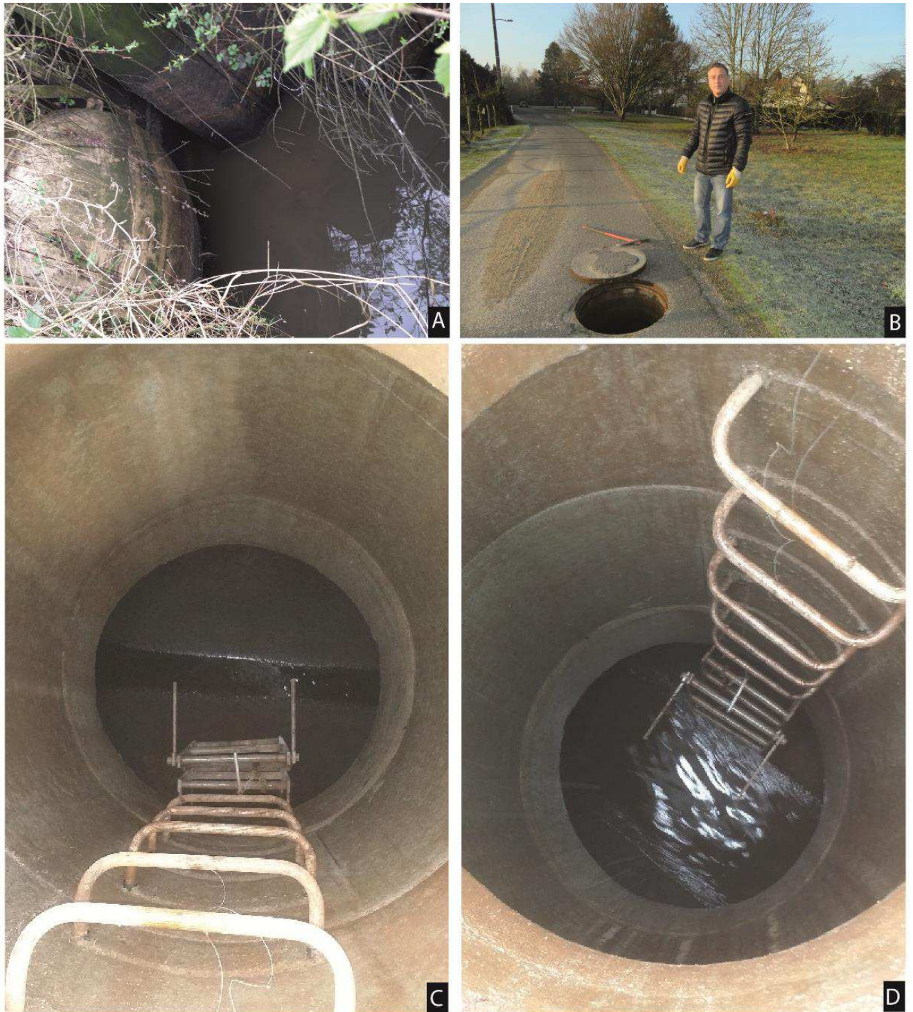
Figure 2-7: A : Photo du point de rejet du réseau d'EP à l'aval du bassin versant (17 /04/ 2015). B : Photo du regard du réseau EP à l'aval du bassin versant d'Ormes où les prélèvements ont été effectués. C : Photo du regard du réseau EP à l'aval du bassin versant d'Ormes par temps sec (13/05/2016). D : Photo du regard du réseau EP à l'aval du bassin versant d'Ormes par temps de pluie (23/05/2016).
