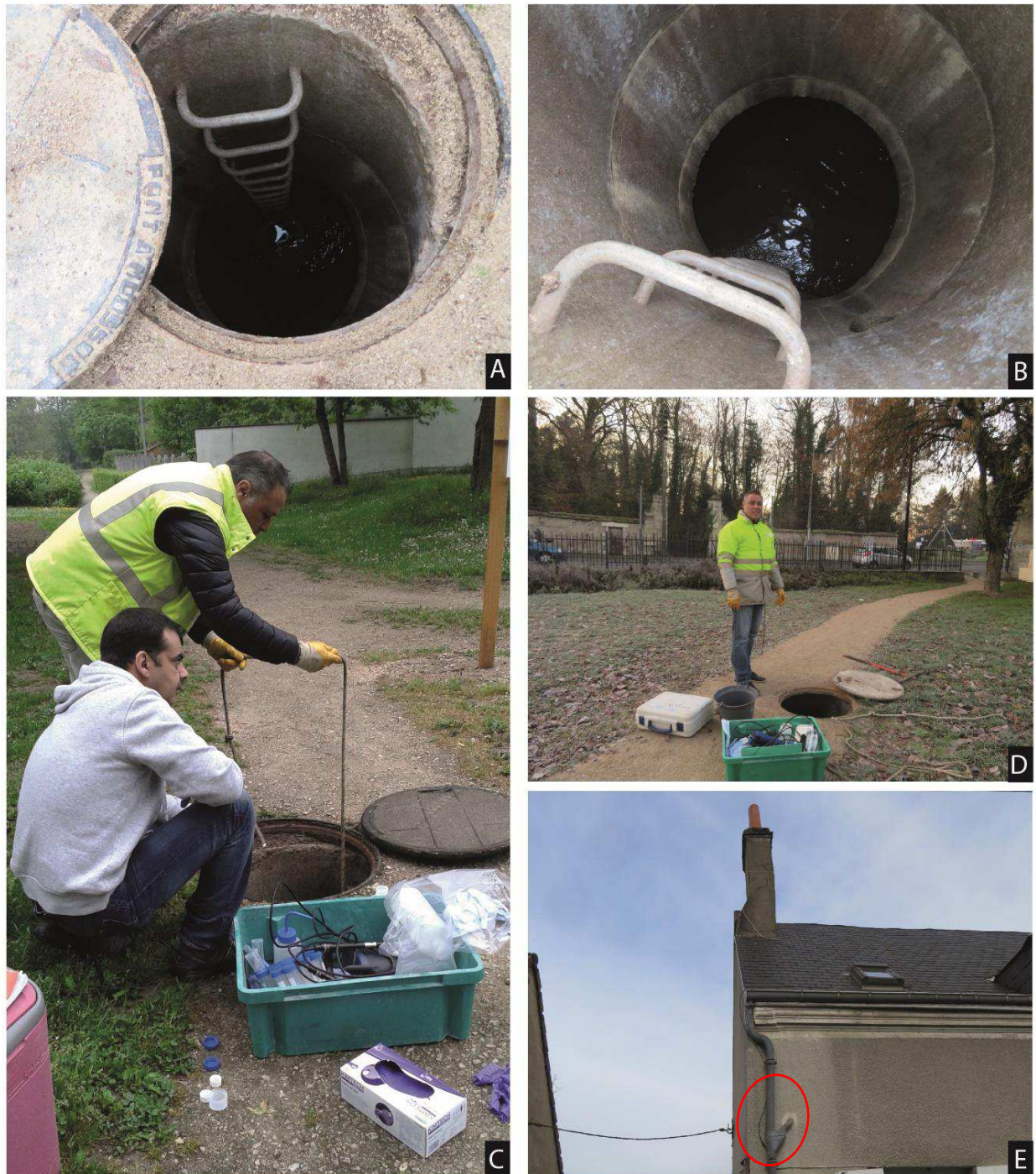
Figure 2-5: A : Photo du regard du réseau EP en aval du bassin versant de l'Egouttier par temps sec (12/12/2016). B : par temps de pluie (01/03/2017). C et D : Photos du regard du réseau EP en aval du bassin versant de l'Egouttier où les prélèvements ont été effectués. E : Raccordement d'une évacuation d'EU au réseau d'EP.
