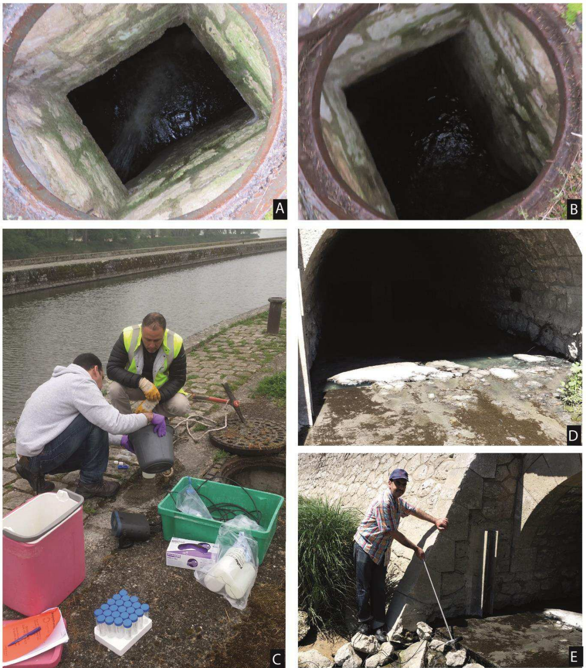
Figure 2-9: A : Photo du regard du réseau EP à l'aval du bassin versant de la Corne par temps de pluie (07/03/2017). B : Photo du regard du réseau EP à l'aval du bassin versant de la Corne par temps sec (12/12/2016). C : Photo du regard du réseau EP en aval du bassin versant de la Corne où les prélèvements ont été effectués. D : Exutoire des eaux de ruissellement du bassin versant de la Corne. E : Mesure de la vitesse des RUTP.
