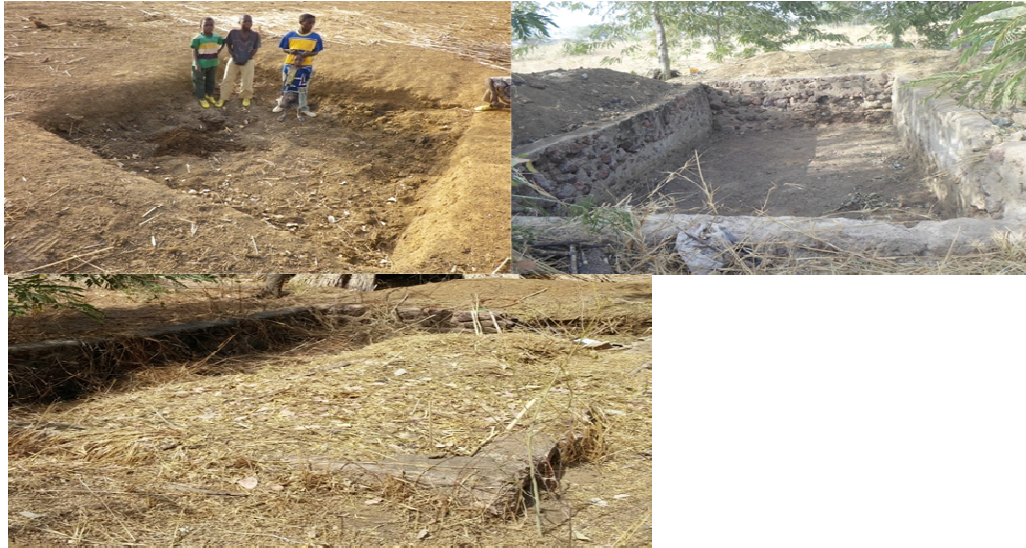
Figure 19 : Creusage, stabilisation et remplissage de la fosse à compost (Sampieri 2014, Auteur Coulibaly Aboubacar)
