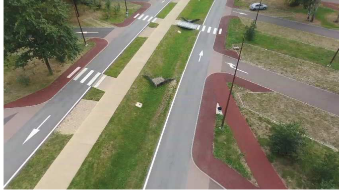
Figure 4.3. – Vue de drone du parking.
