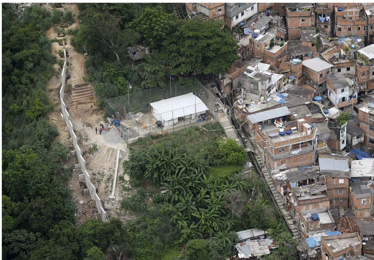
Figure 66 – Mur de béton entourant Santa Marta
