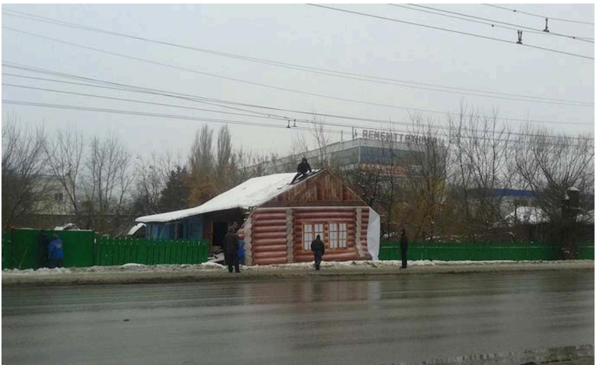
Figure 78 – Des ouvriers couvrent une maison délabrée de Penza avec un trompe l'œil
