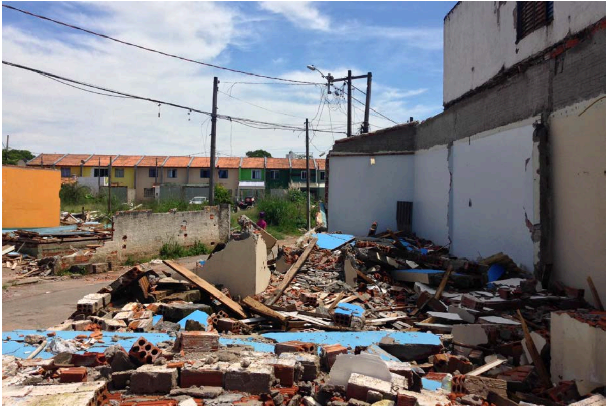
Figure 83 – Gravats volontairement laissés sur le sol à Vila Torres, Curitiba
