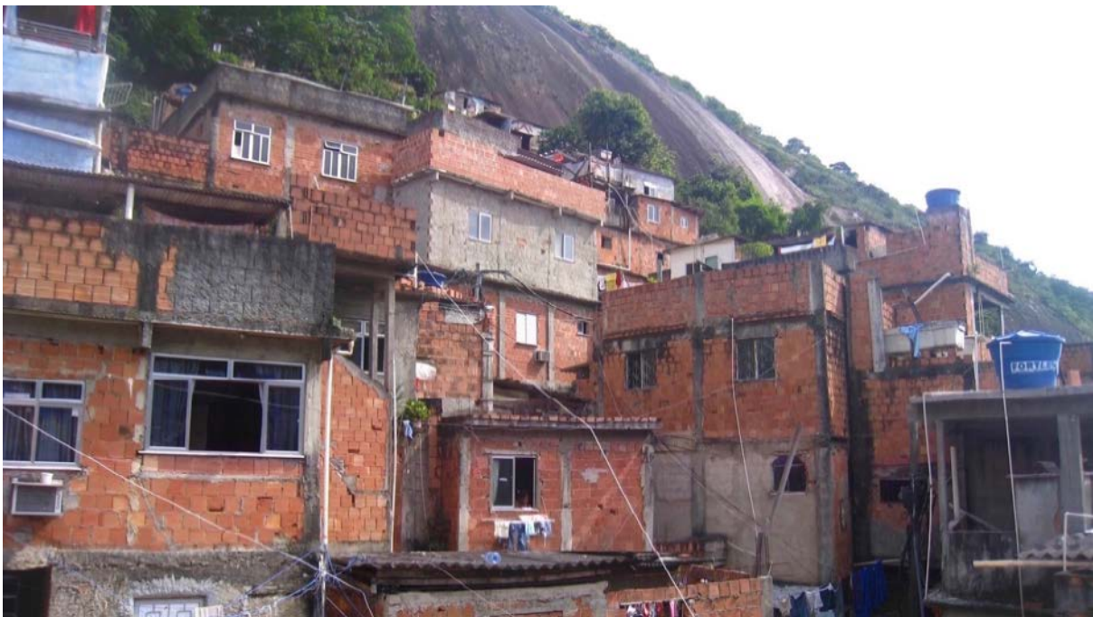
Figure 55 – Mur de brique sans revêtement - favela Rocinha, Rio de Janeiro
