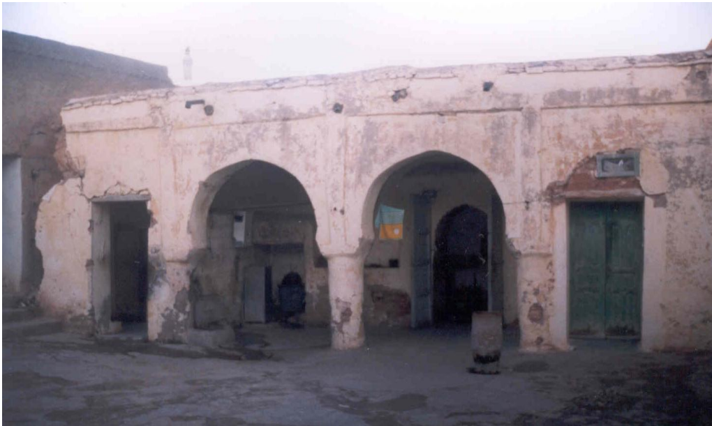
Photo ancienne du côté est de l'aile droite ; on peut voir la cuisine et les arcs dont il n'y a plus de traces aujourd'hui. (Photos provenant des archives de la Zaouïa)
