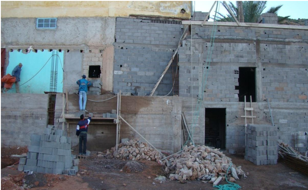
Photo d'une partie des travaux entrepris par le Shaykh actuel à la Zaouïa pour l'agrandissement de l'école traditionnelle ( Al-madrassâ al-'îqâ ) (photo prise par le chercheur)
