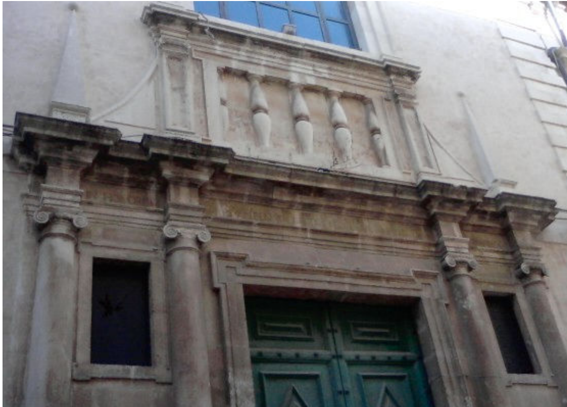
45. Détail de la porte de l'église San Benedetto à Syracuse.
