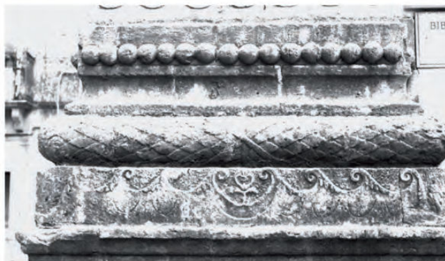
4. Base du pilier d'angle composite du monastère de Santa Chiara à Salemi.
