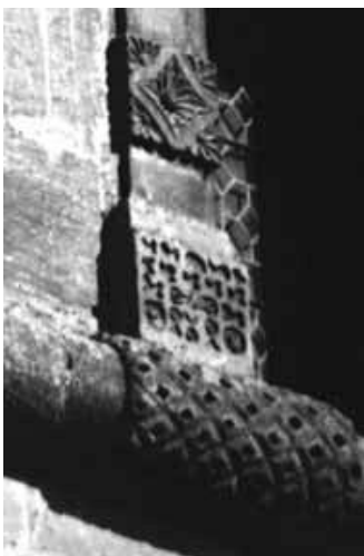
48. Détail d'une fenêtre du château de Cons-la-Grandville avec ses faux hiéroglyphes.
