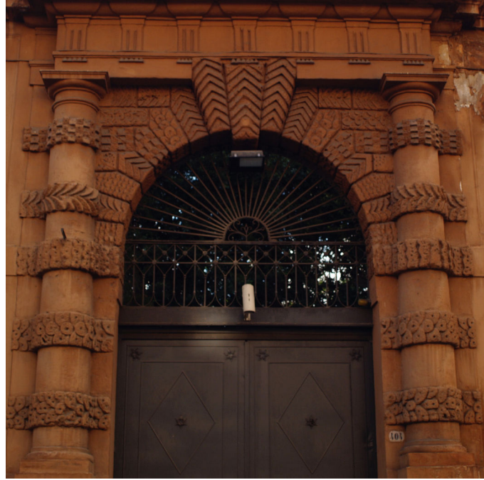
91. Détail des bandes à bossage de la porte de la villa Castillo Sant'Isidoro Zati à Palerme.
