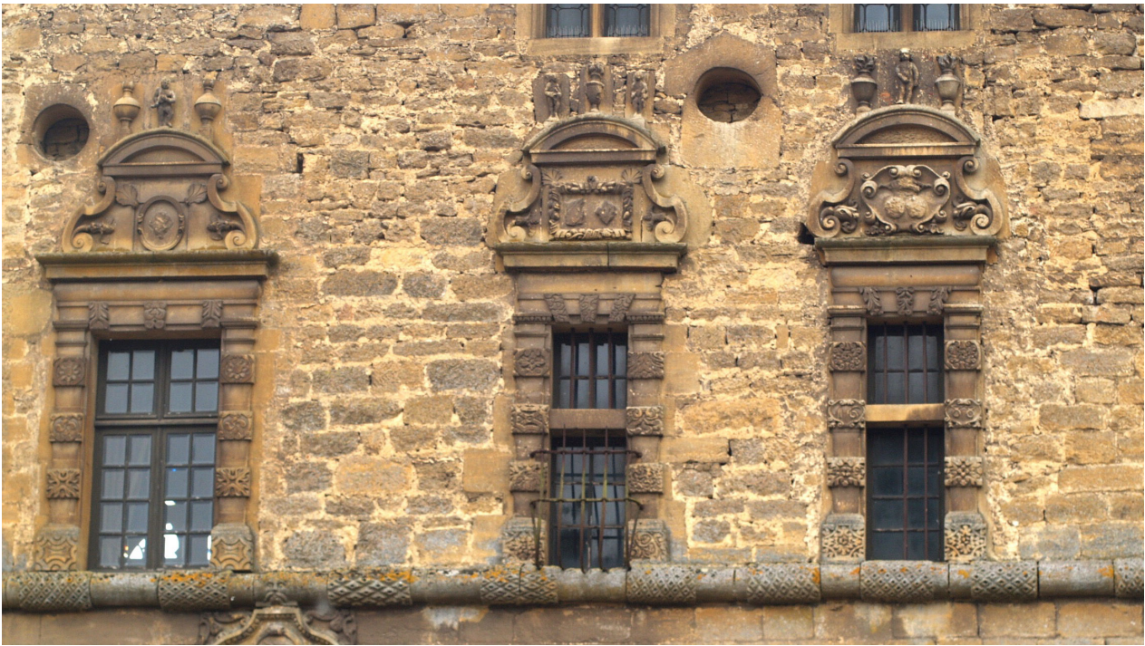
17. Fenêtres de la façade nord du château de Cons-la-Grandville.
