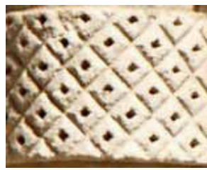
209. Détail du bossage de la porte de l'hôtel du baillage, Vézelize.
