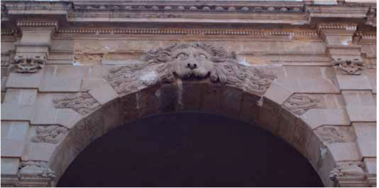
40. Porta Garibaldi, vers la ville de Marsala.
