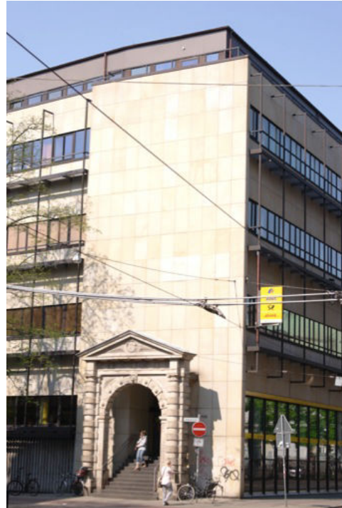
14. État actuel de la porte de la résidence du doyen Joachim Hincke, plaquée contre le nouveau bâtiment de la Poste de Brême.
