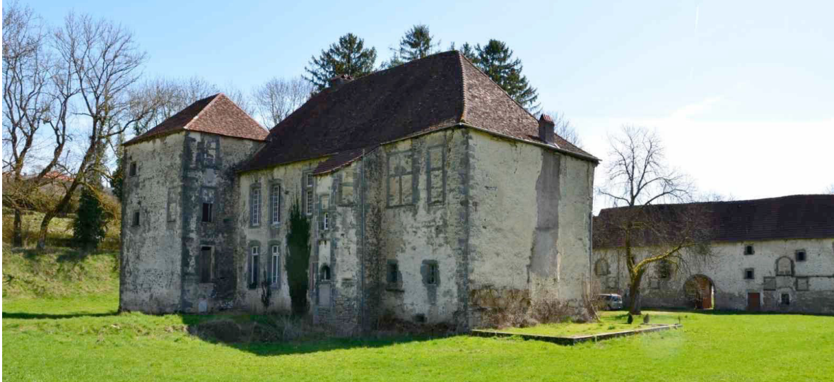
68. Façade postérieure du corps de logis et écuries du château d'Harcourt, Isches.
