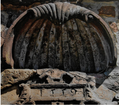
17. Détail des ruines du Château d'Uslar avec la coquille maladroitement insérée dans le mur au-dessus de la date « 1559 ».
