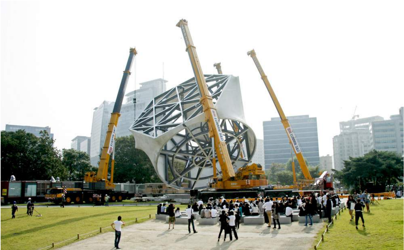
OMA, Prada Transformer , Guggenheim labs , 2007-2009 ill. 43 : Montage de la structure et grue servant au déplacement.
