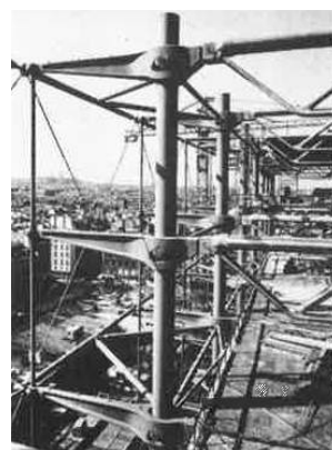
Ill. 32, 33, 34 : Richard Rogers et Renzo Piano, Centre Georges Pompidou , 1977. Photographies prises lors de la construction. DR
