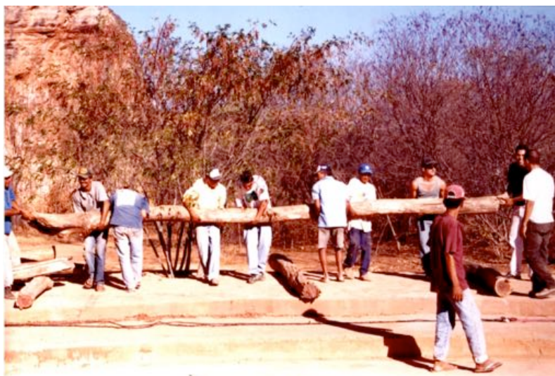
Fig. 40. Paysans de la région travaillant à la construction de la scène dans le site BPF, 2000. © FUMDHAM.
