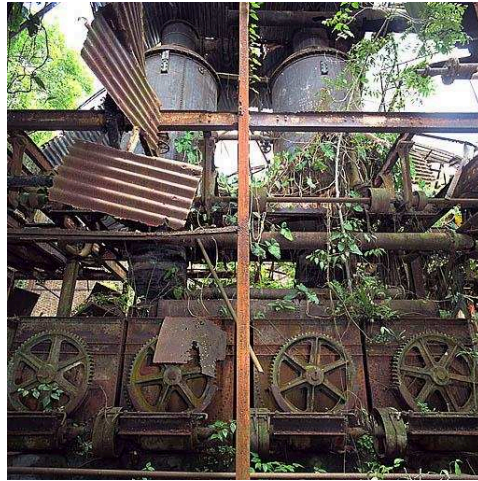
Figure 55 : Vue des malaxeurs de Lamirande. Cliché M. Heller, 2001.
