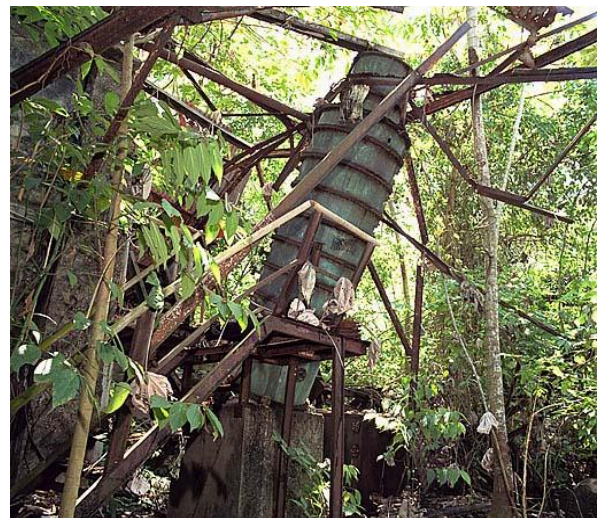
Figure 60 : L'alambic de l'usine du Rorota. M. Heller, 2001.
