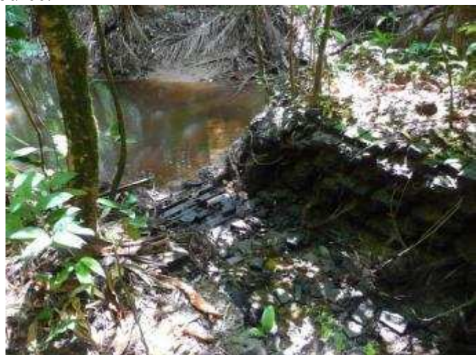
Figure 4 : L'écluse de l'habitation La Constance. Cliché D. Hanriot, 2009.
