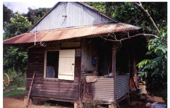
Figure 66 : La maison du gardien de l'usine du Rorota. Y. Lentin, 1998.
