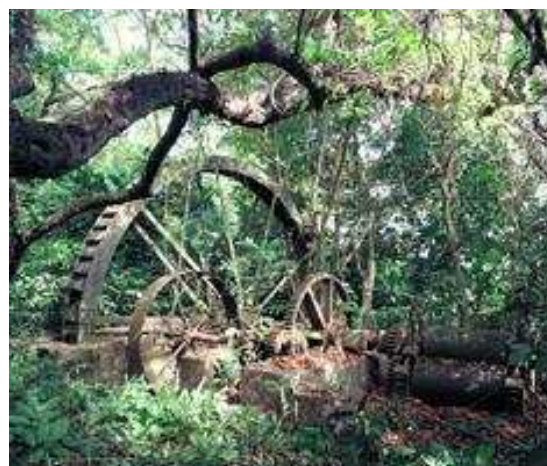
Figure 52 : La roue à eau de l'usine Saccharin. Cliché M. Heller, 2001.
