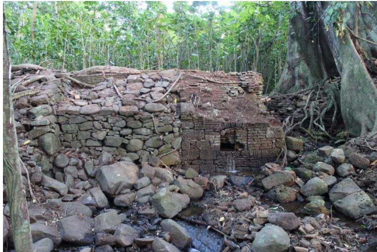
Figure 16 : Le barrage poids de l'habitation Beauregard. Cliché N. Cazelles, 2014.
