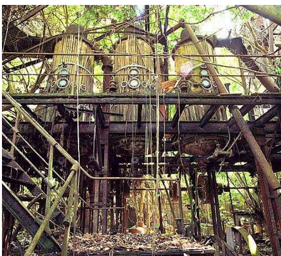
Figure 59 : Les machines de Wetzell de l'usine du Rorota. M. Heller, 2001.
