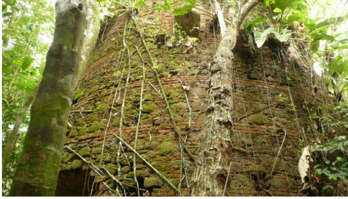
Figure 17 : Le moulin à vent de Macouria. On remarque l'alternance de pans de pierres entre 3 rangs de briques. Cliché N. Cazelles, 2009.
