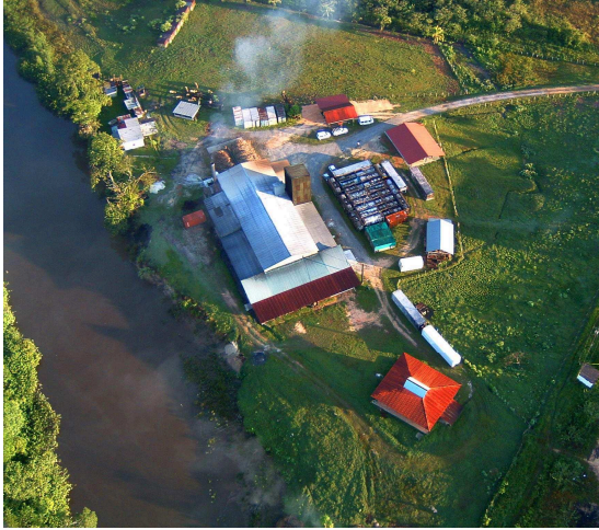
Figure 70 : L'usine Saint-Maurice en 2012. D. Béreau.
