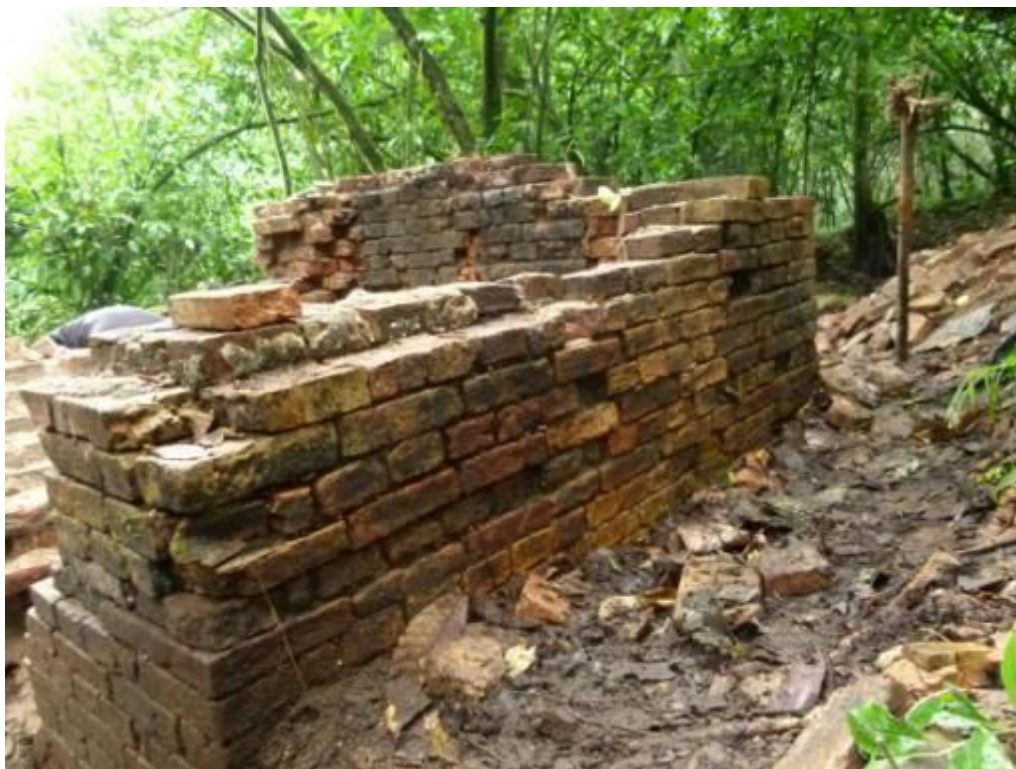
Figure 111 : vue de détail de la façade extérieure ouest. 2012
