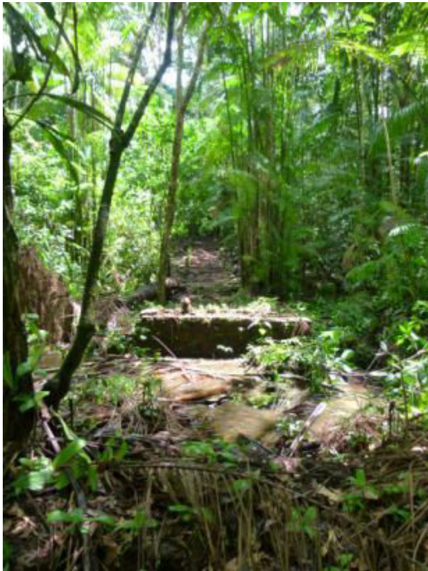
Figure 31: vue de l'escalier depuis la pile est. 2010
