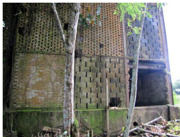
Figure 5 : Claustre en croix (type3), façade Nord de la sucrerie
