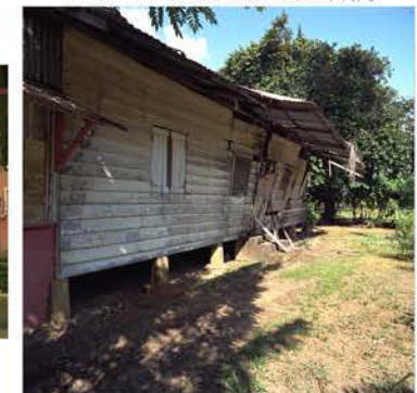
LOGEMENT Maison contremaitre (7).TIF
