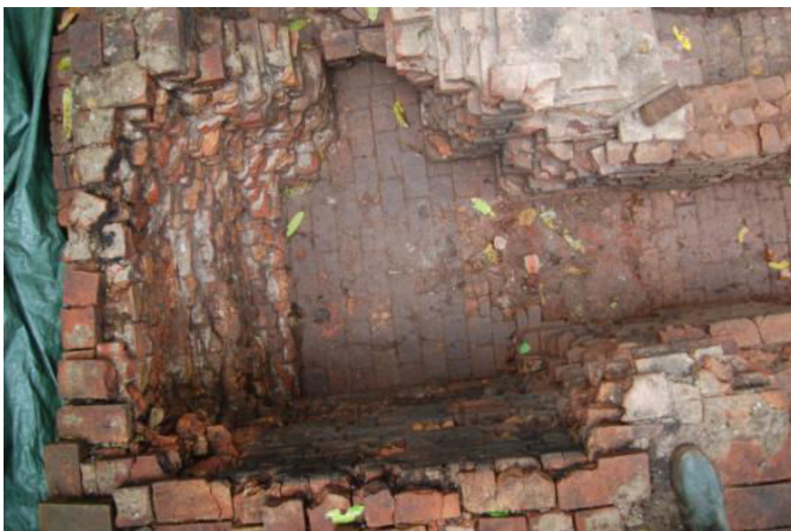
Figure 113 : vue des murs 05 et 06 qui s'encastrent dans les piliers de la cheminée
