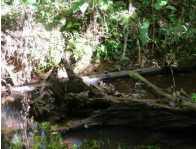
Figure 1 : poutre d'un pont ?
