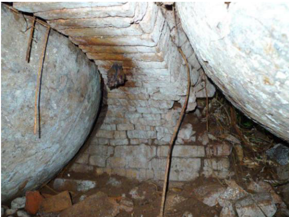
Figure 12 : le tunnel de chauffe
