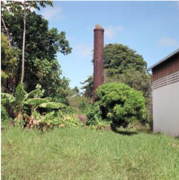
Figure 3 : la cheminée (cliché M. Heller)
