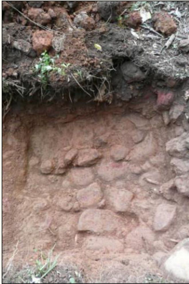
Figure 73 : semelle de fondation du mur 16.
