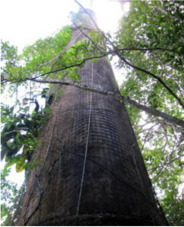
Figure 41 : Les haubans décrochés ou détendus de la cheminée
