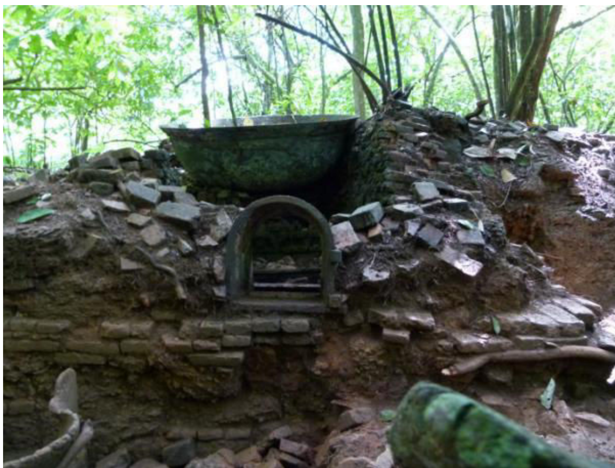
Figure 75 : vue de détail du foyer. On observe le lit de briques sur lequel repose le foyer en fonte. 2011
