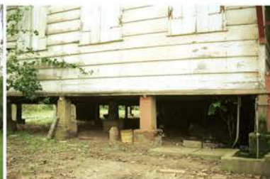
LOGEMENT Maison contremaitre (6).tif
