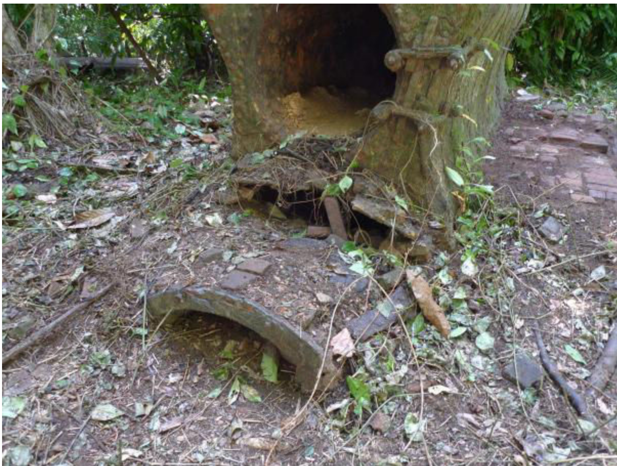
Figure 7 : la chaudière encore en place
