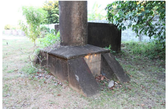
Figure 4 : le socle de la cheminée
