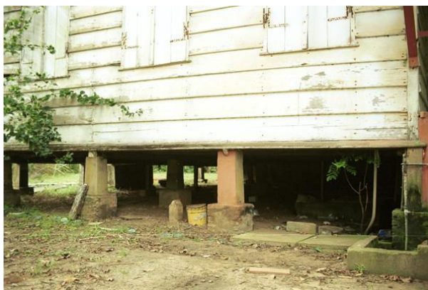
Figure 3 : Détail du soubassement de la maison du contre-maître de l'usine du Rorota. Cliché MP. Mallé, DRAC Guyane, service de l'inventaire, 2001.
