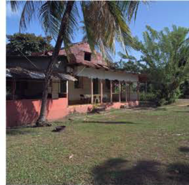
LOGEMENT Maison contremaitre (8).TIF
