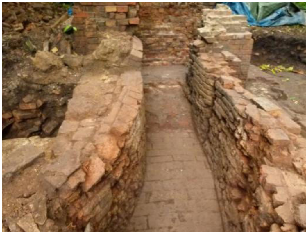
Figure 123 : le tunnel de chauffe n°1
