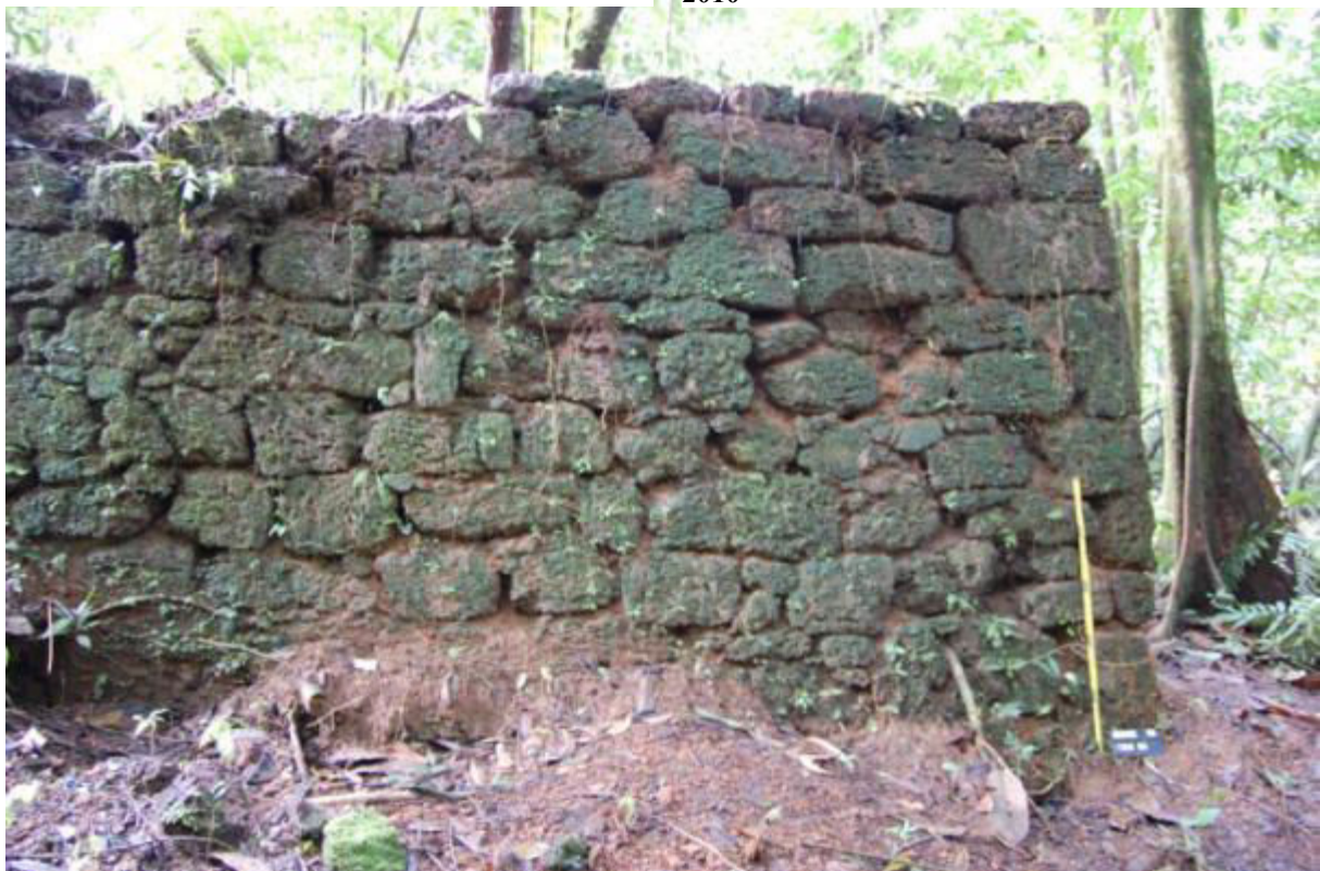
Figure 33 : mur de terrasse, face ouest. 2010
