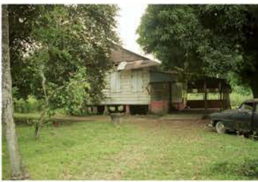
LOGEMENT Maison contremaitre.tif
