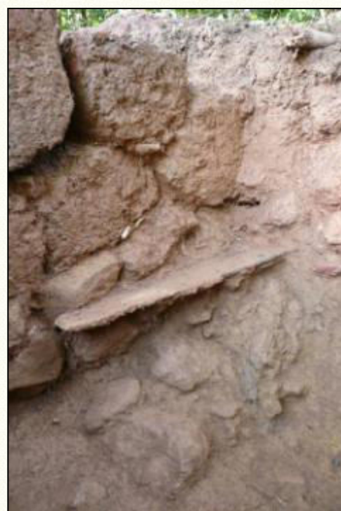
Figure 72 : lame métallique dans la tranchée de fondation.
