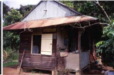
LOGEMENT Gardien (1).jpg
