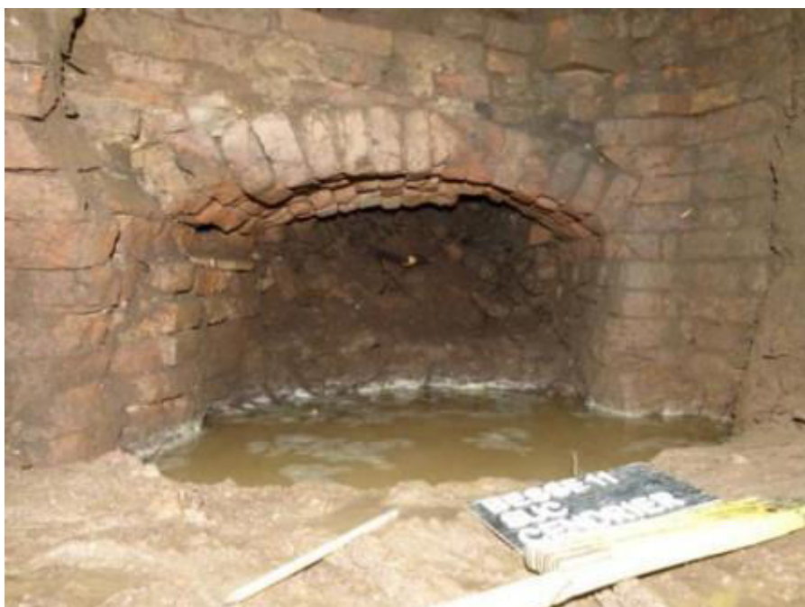
Figure 78 : vue du cendrier et du tunnel de chauffe enchâssé dans la cuirasse ferralitique. 2011
