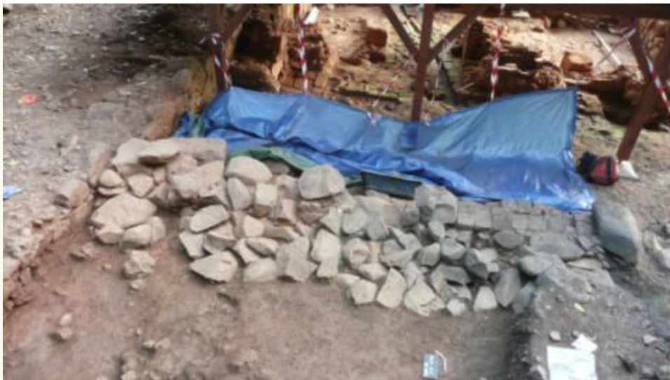
Figure 23 : vue du remblai de construction derrière l'embranchement mur 17
