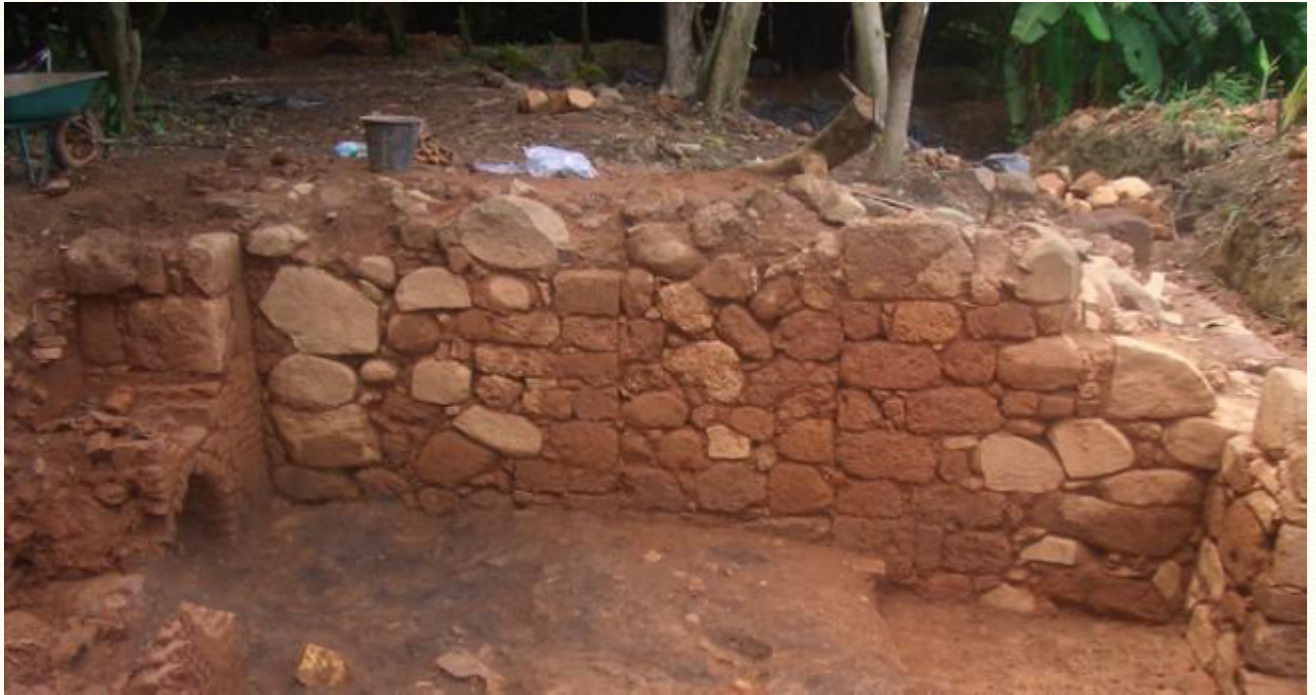
Figure 109 : porte bouchée dans le mur 13
