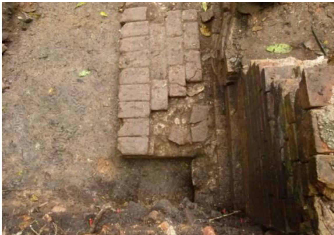
Figure 112 : vue du socle de la cheminée arraché. 2012
