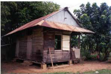
LOGEMENT Gardien (2).jpg
