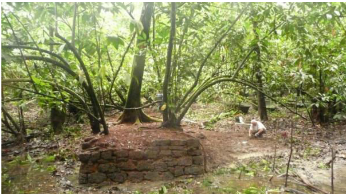
Figure 6 : pile ouest du pont 1. 2010
