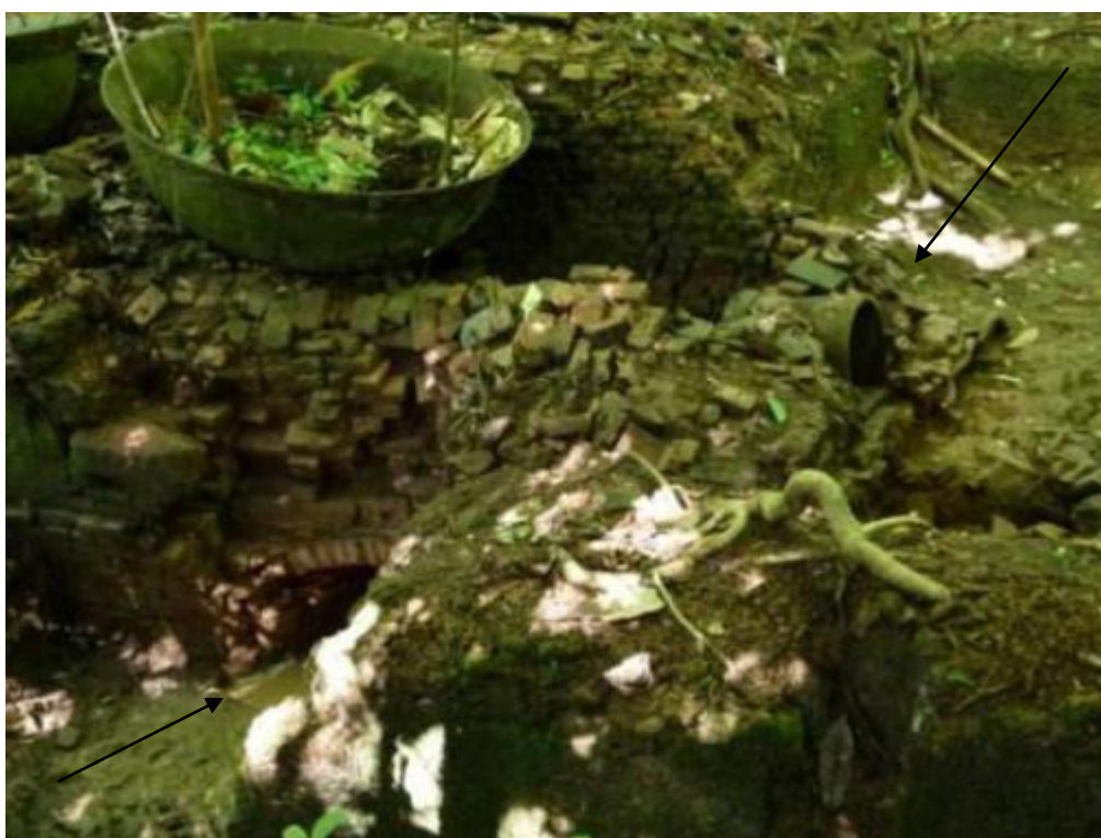
Figure 77 : vue du foyer et du cendrier. 2011
