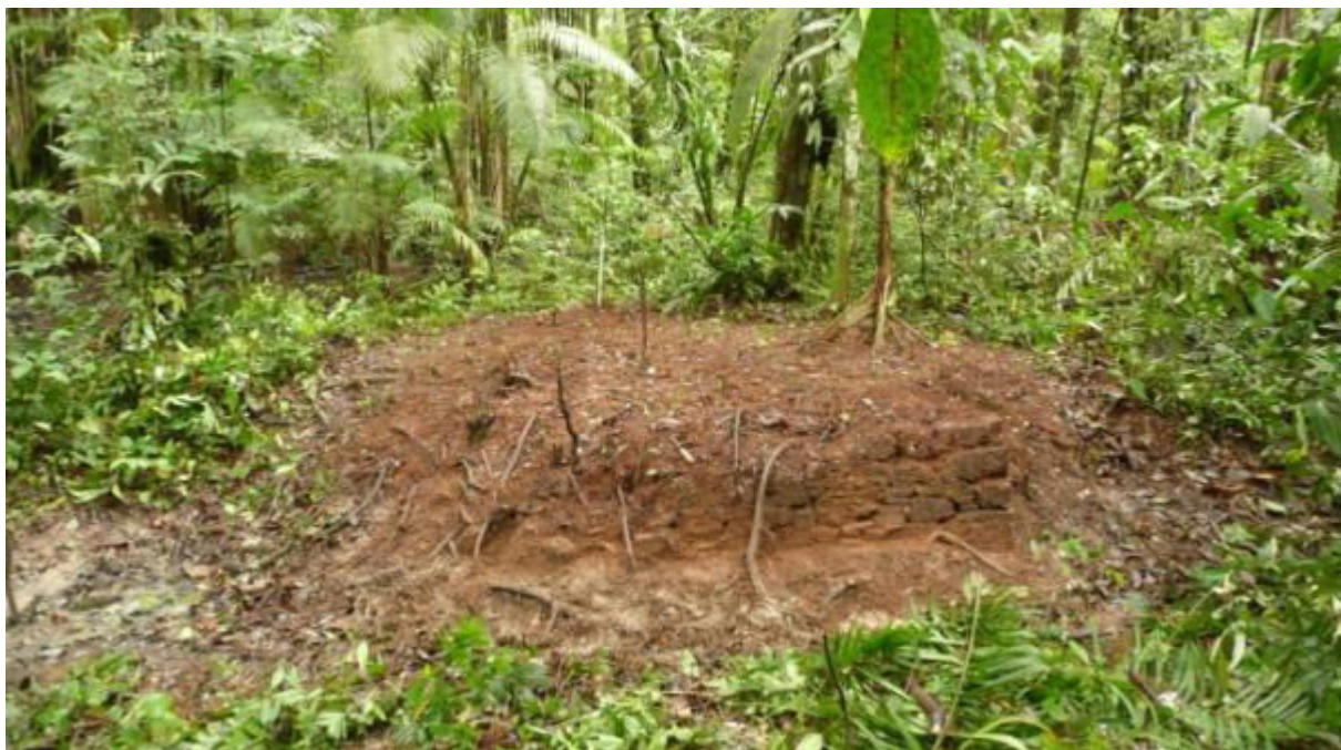
Figure 7 : pile est du pont 1. 2010
