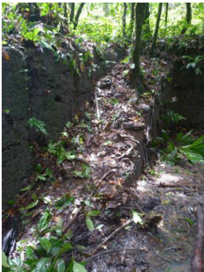
Figure 13 : escalier d'accès à l'usine
