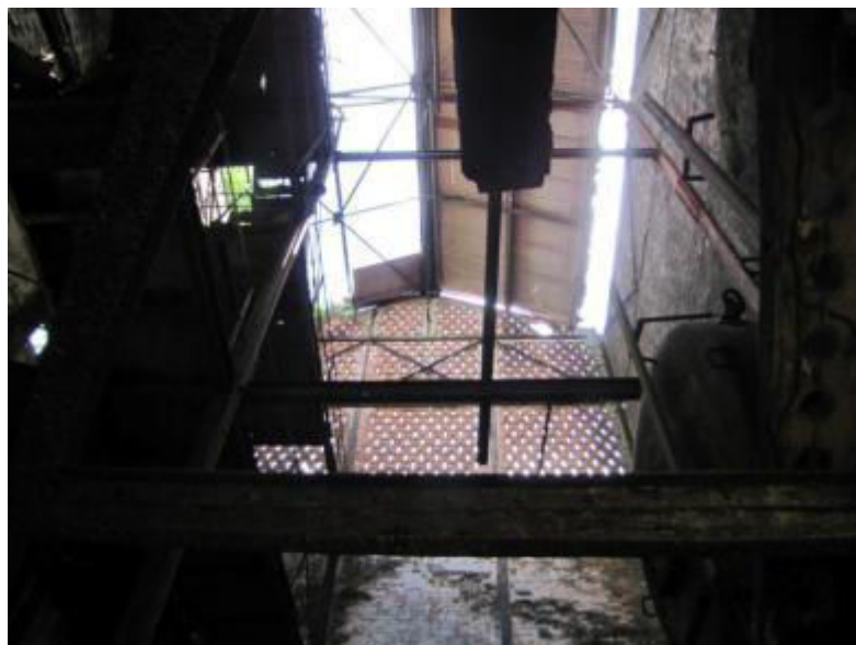
Figure 37 : La toiture de la tour de a distillerie et les planchers métalliques
