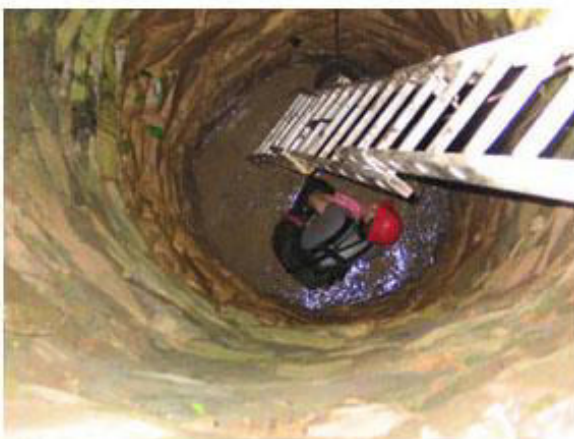
La fouille de l'intérieur du puits
