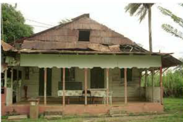
LOGEMENT Maison contremaitre (4).tif
