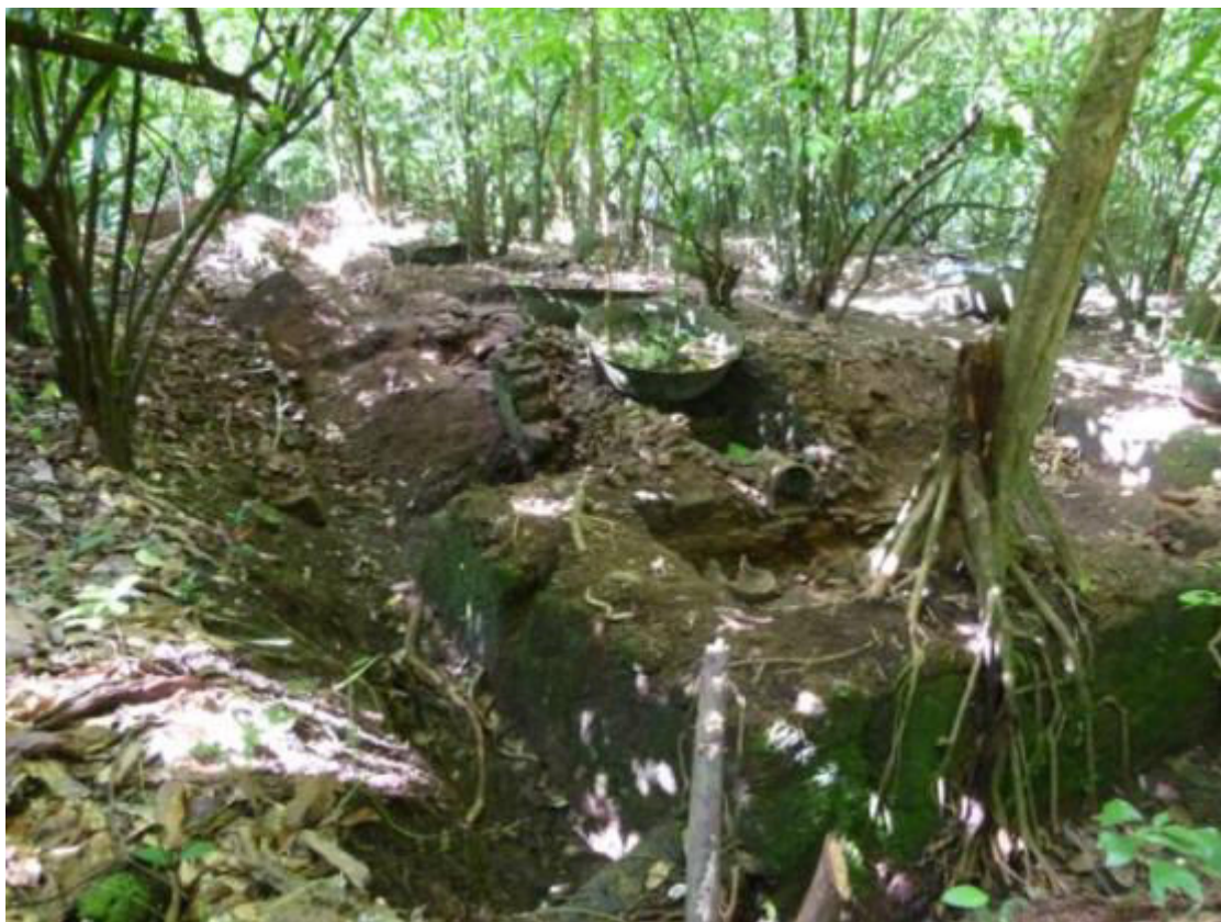
Figure 80 : vue d'ensemble du tunnel de chauffe. 2011
