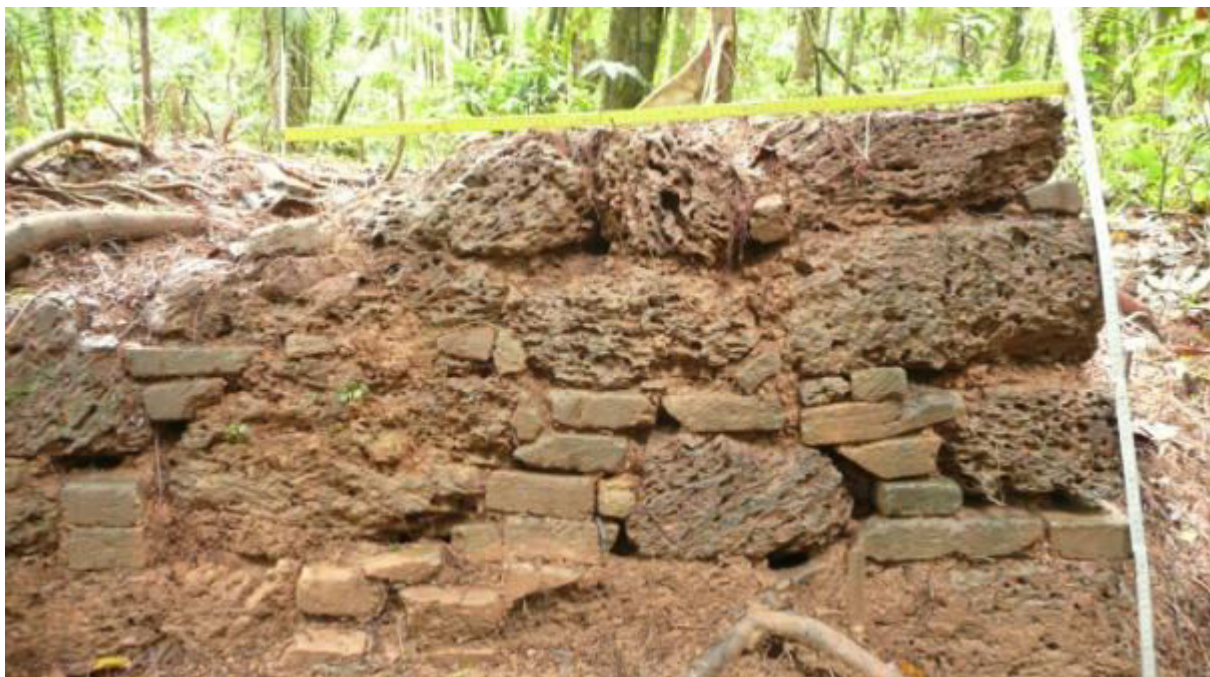
Figure 9 : inclusion de briques dans le mur. 2010
