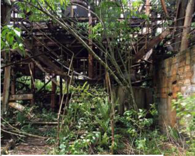
Figure 22 : L'escalier d'accès au semi-plancher
