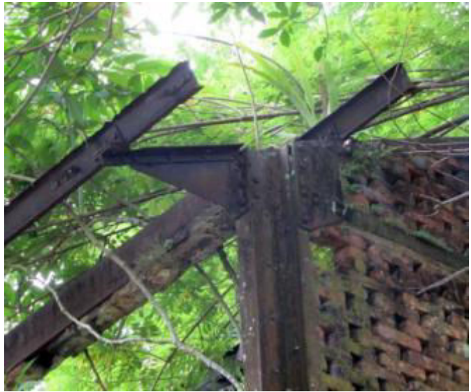
Figure 12 : Avant-toit angle sud-ouest distillerie
