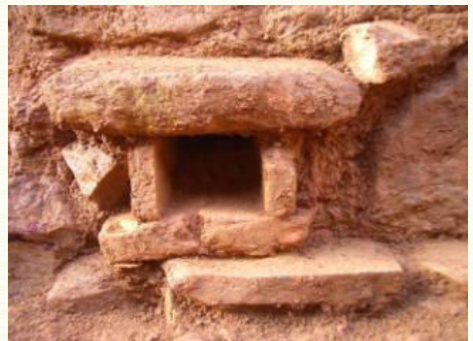
Figure 5 : détail de la sortie de la canalisation
