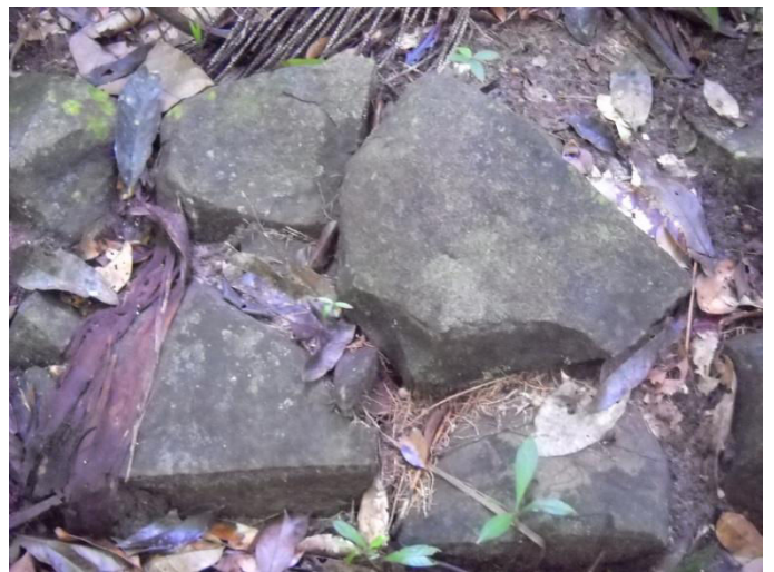
Figure 4 : soubassement en grison
