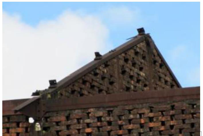
Figure 15 : Hébergement du pignon porteur de la distillerie
