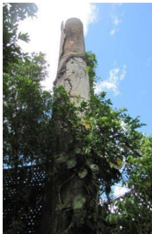
Figure 30 : Vue de la cheminée.
