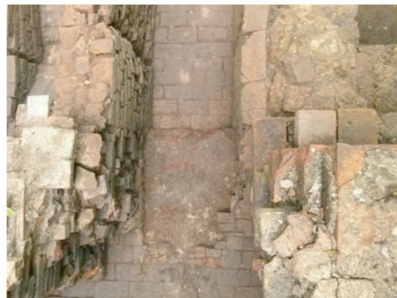
Détail du passage cheminée - tunnel de chauffe 1 Le dallage bombé a disparu.
