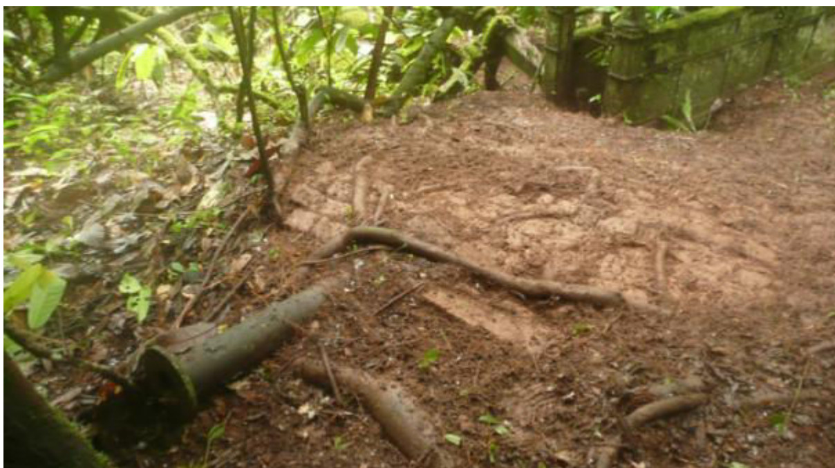
Figure 24 : vue de détail. 2010
