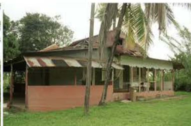
LOGEMENT Maison contremaitre (5).tif
