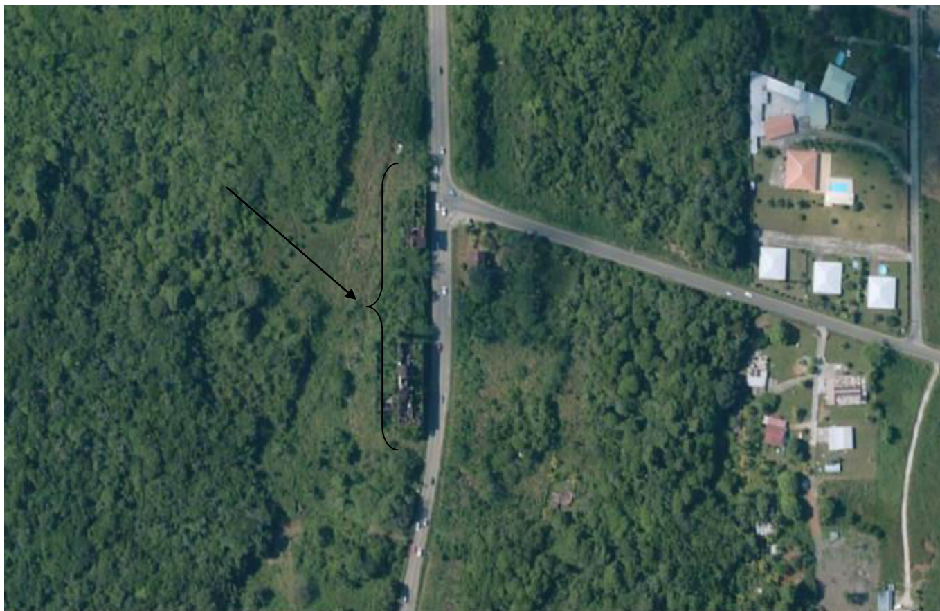
Figure 46 : Vue aérienne de l'usine.
