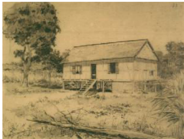
Figure 2 : une maison de concessionnaire à Saint-Maurice. Album des établissements pénitentiaires, 1884, CAOM, cliché M. Heller, 2001.
