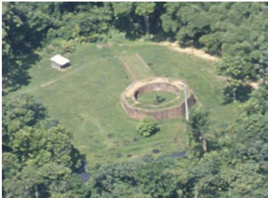
Figure 4 : vue aérienne du moulin à mules. S. Réol.
