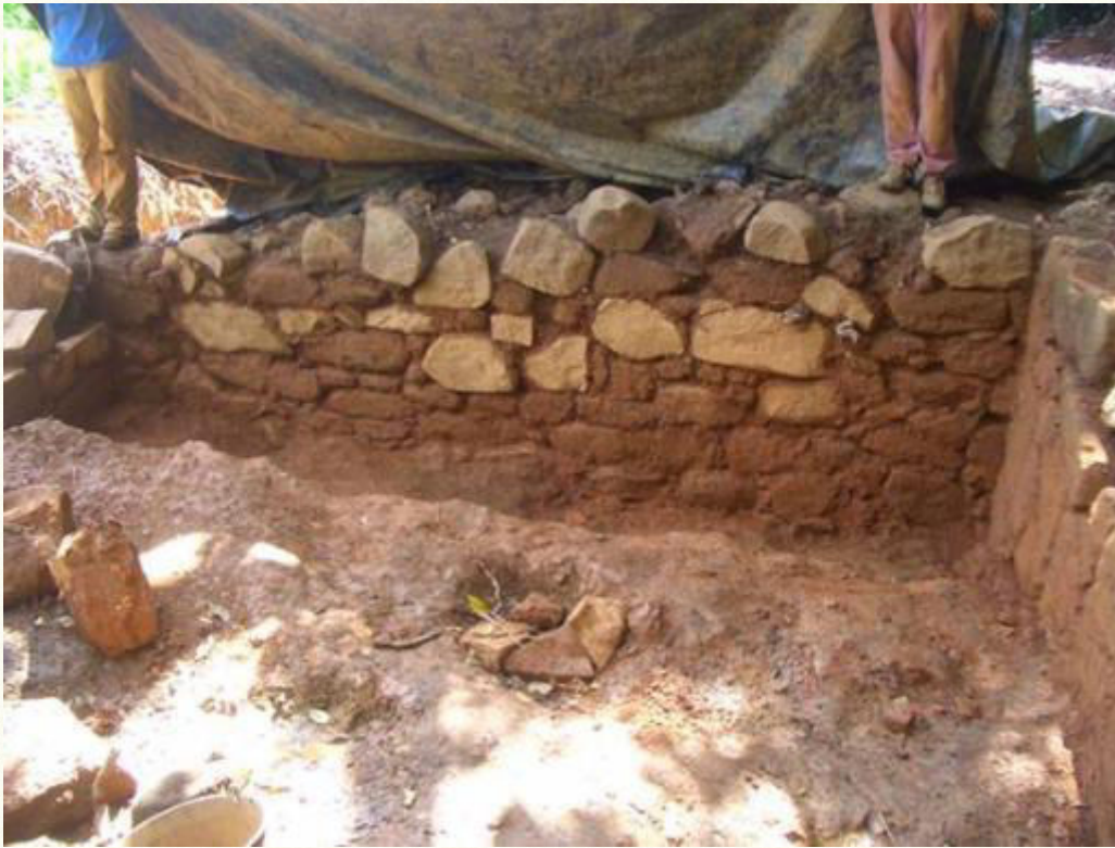
Figure 64 : vue de parement intérieur du mur 11.
