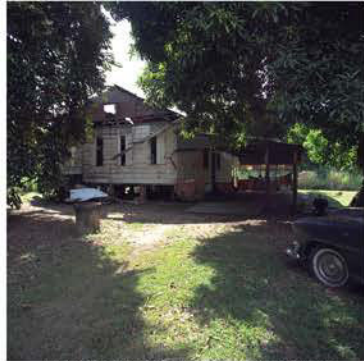
LOGEMENT Maison contremaitre (9).TIF
