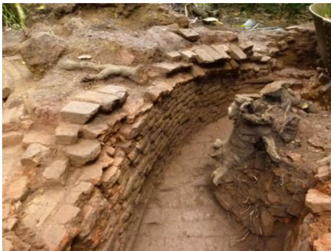
Figure 124 : vue du tunnel de chauffe n°1 se connectant à l'équipage
