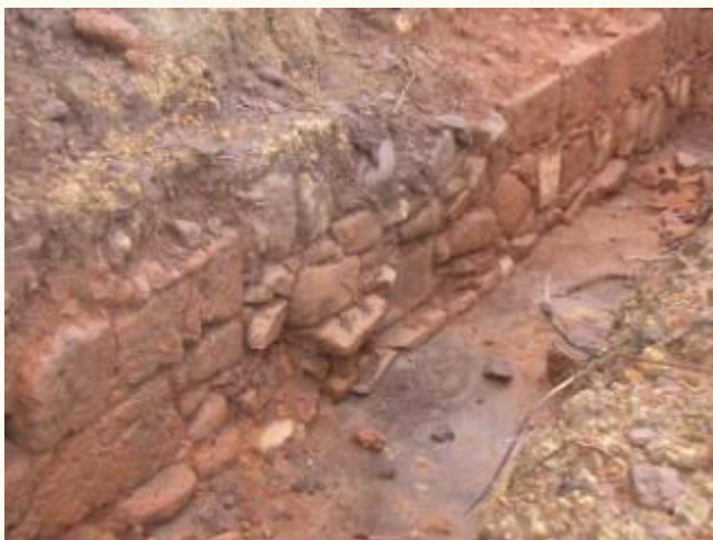
Figure 6 : sortie de canalisation dans le mur 10.
