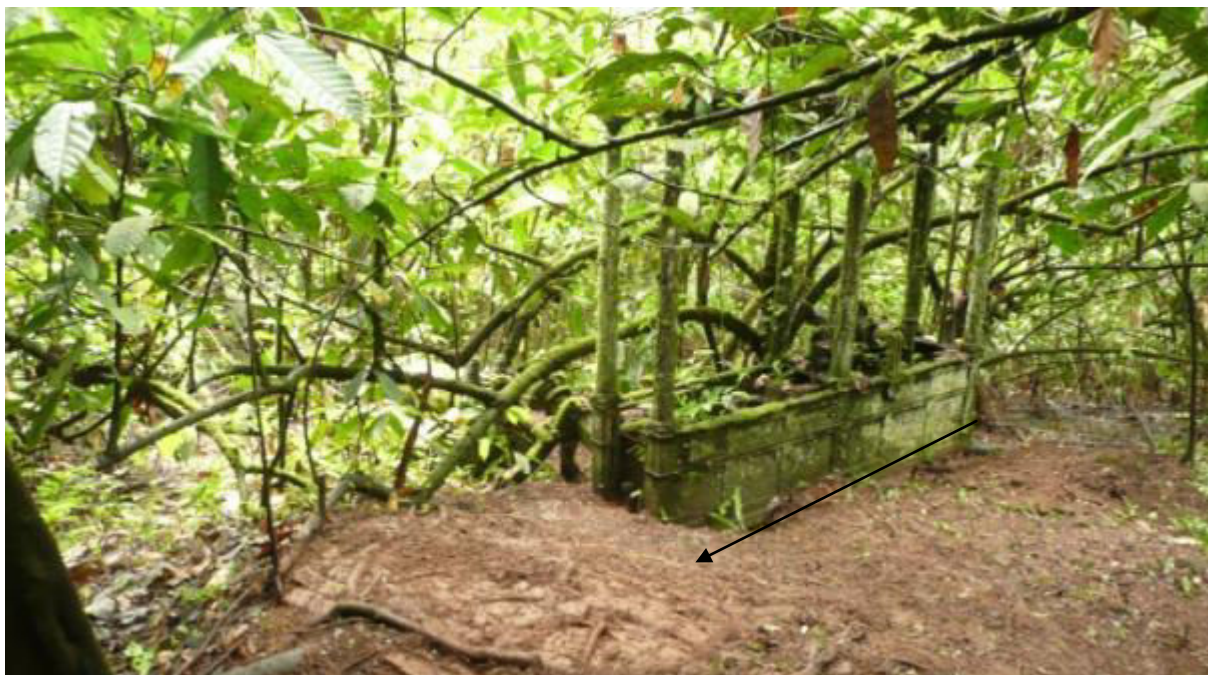
Figure 23 : vue du sol en briques. 2010
