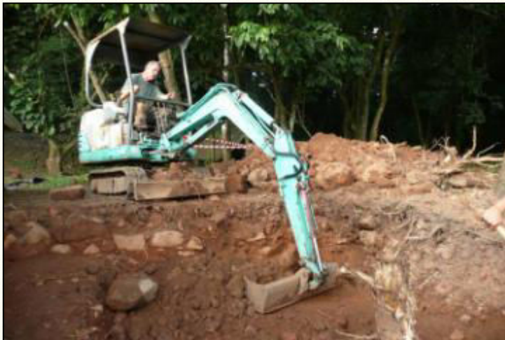
Figure 86 : dégagement du remblai de destruction.
