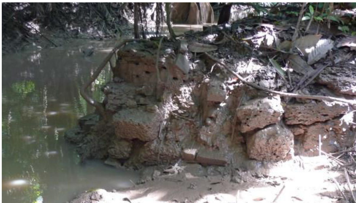
Figure 7 : détail de l'écluse
