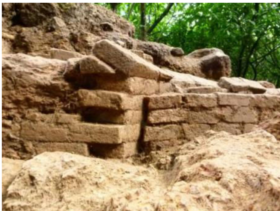
Figure 138 : crénelage de briques pour recevoir l'équipage
