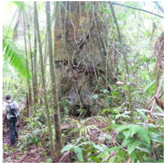
Figure 1 : la cheminée connectée au tunnel de chauffe
