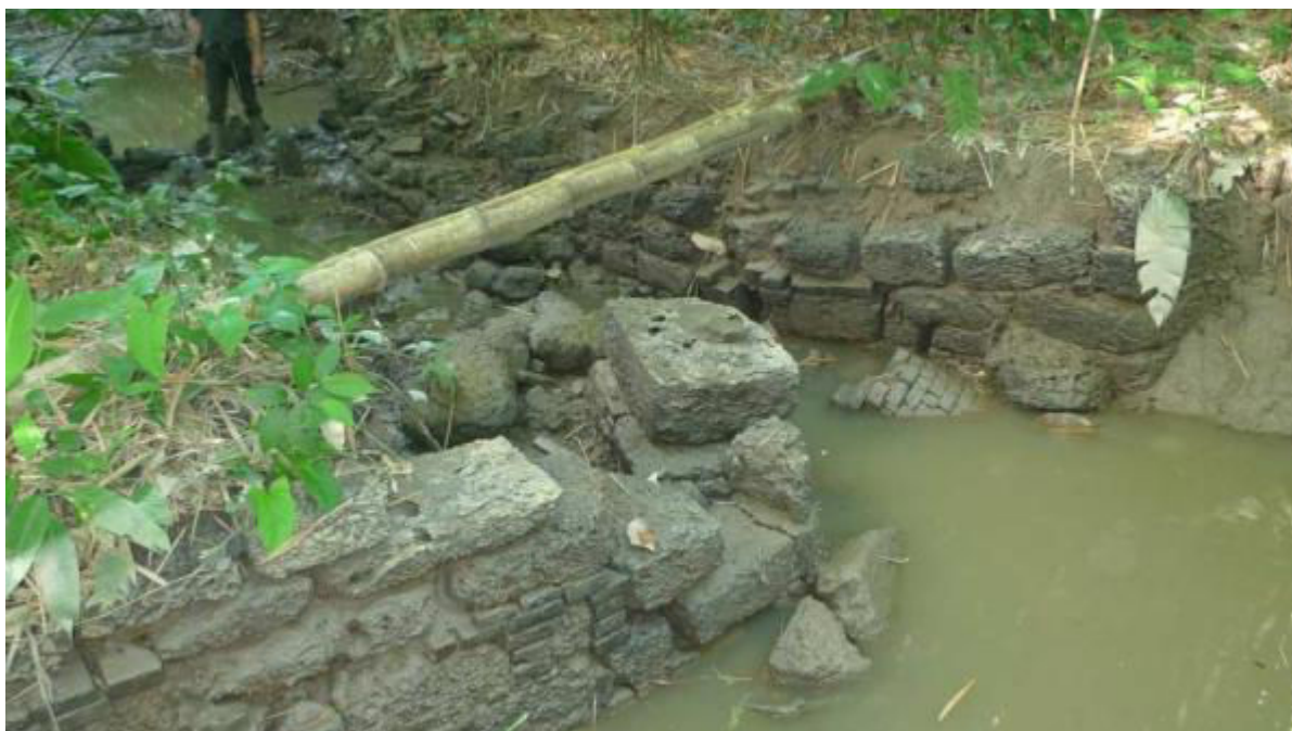
Figure 6 : détail de l'écluse
