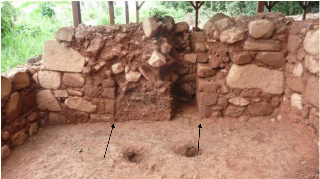
Figure 65 : vue du mur 13 et de la porte bouchée qui a été en partie démontée.
