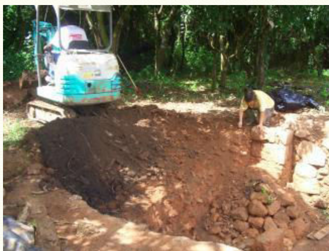
Figure 97 : dégagement de la couche humifère à l'aide d'une mini pelle mécanique.
