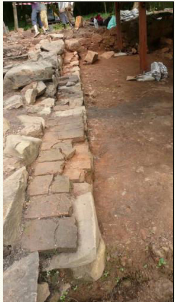
Figure 131 : vue d'ensemble de l'emmarchement
