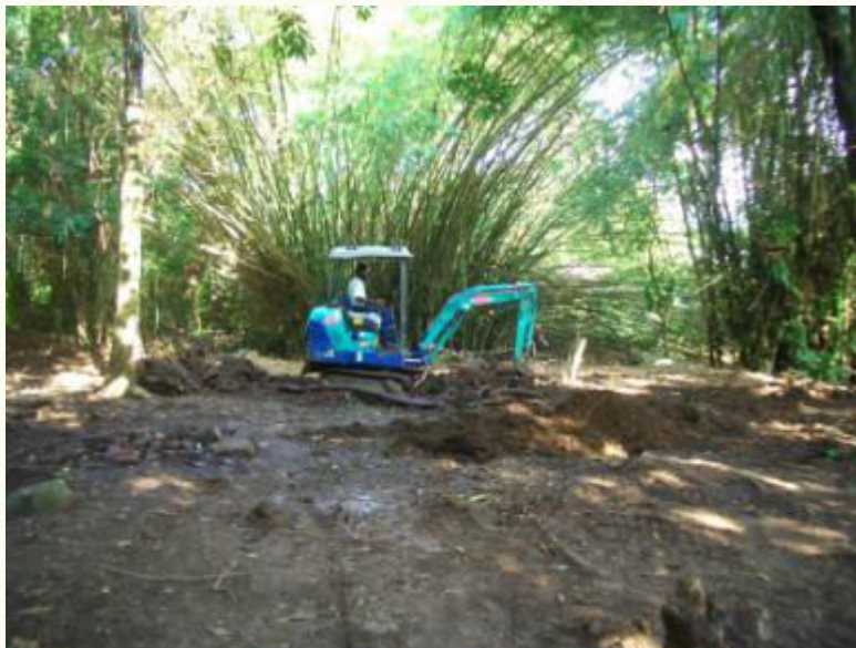
Figure 15 : réalisation de tranchées à la mini-pelle mécanique
