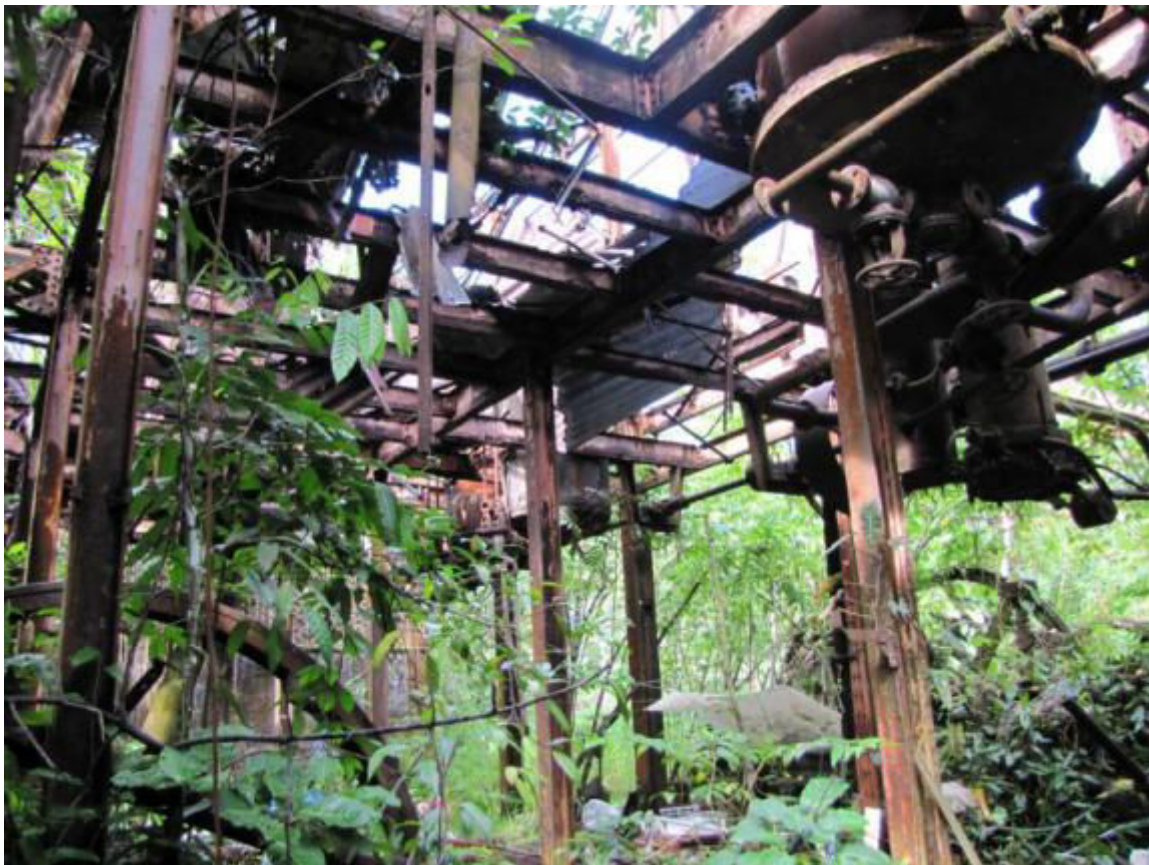
Figure 11 : L'ossature métallique intérieure de la sucrerie : Poteaux et semi-plancher. Rapport Architecte
