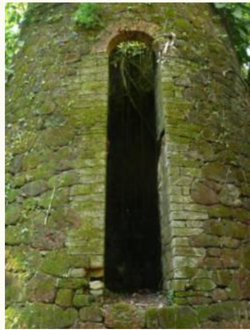
Figure 43 : détail de la deuxième ouverture
