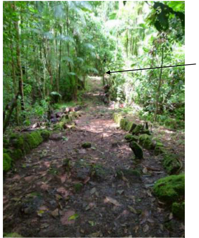
Figure 32 : vue du pont 2 depuis le haut de l'escalier. 2010
