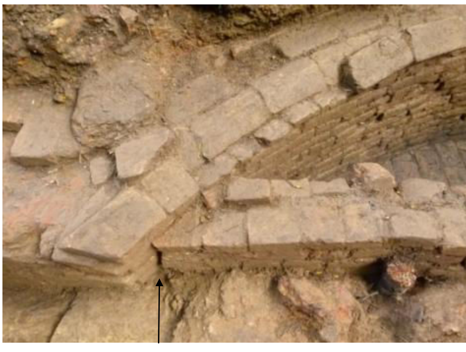
Figure 133 : le mur 11 s'appuie contre le mur 06
