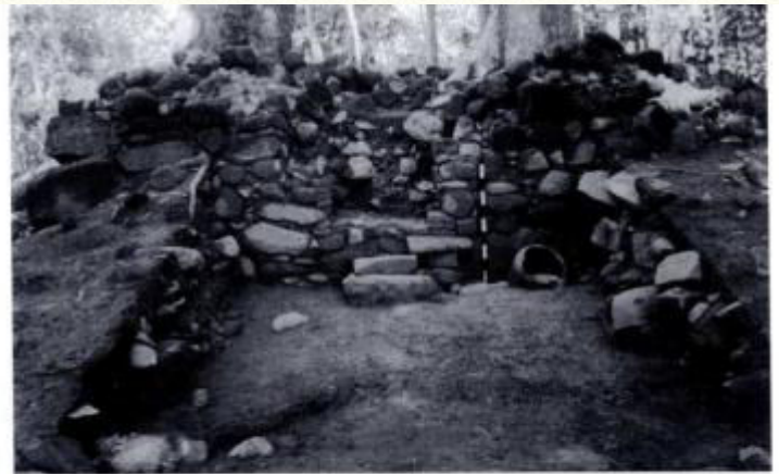
Fig. 7 - Purgerie de Loyola, aspect de l'entrée de l'étuve ? après sondage. On remarque, sur la droite, un gros chaudron en fonte. On notera l'importance de l'éboullis
