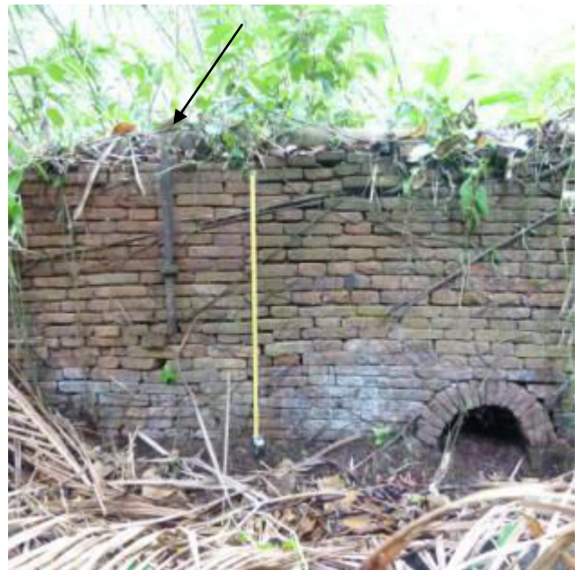
Figure 3 : un étau enserrant la maçonnerie
