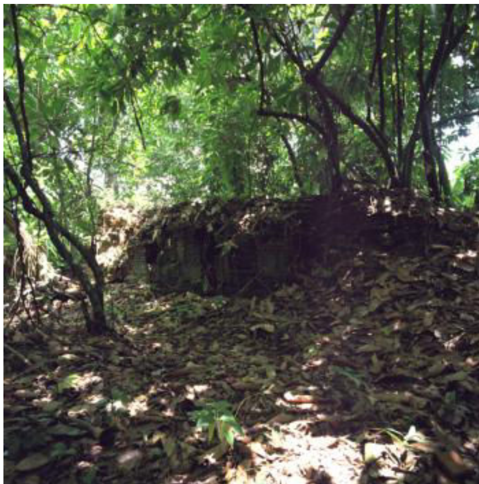
Figure 2 : la structure de chauffe de la sucrerie La Levée
