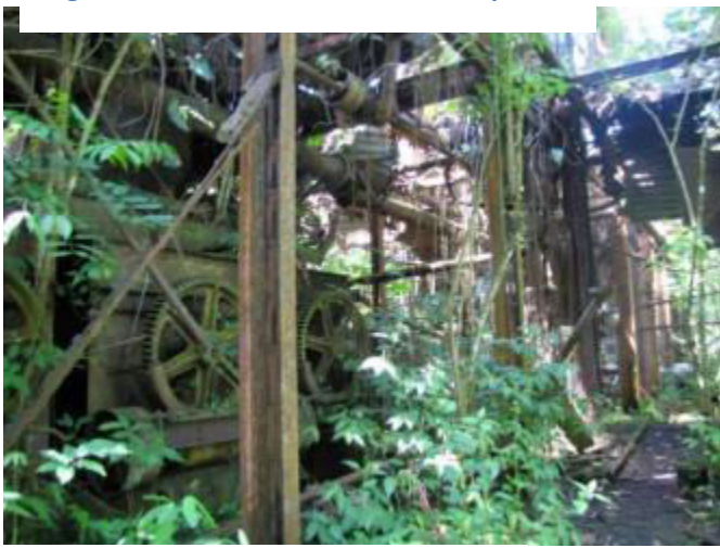
Figure 24 : Passage longeant les malaxeurs
