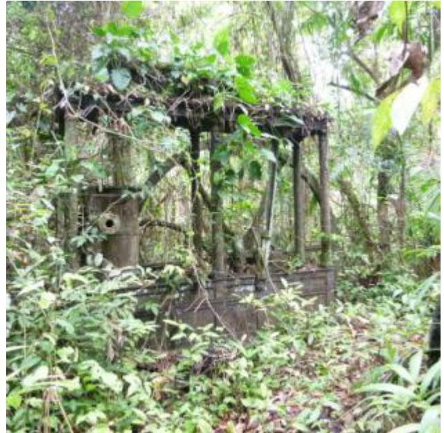
Figure 9 : détail de la machine à vapeur
