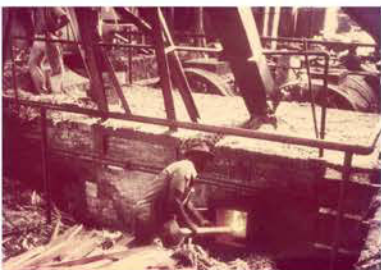
USINE en activité 1984 (9).jpg
