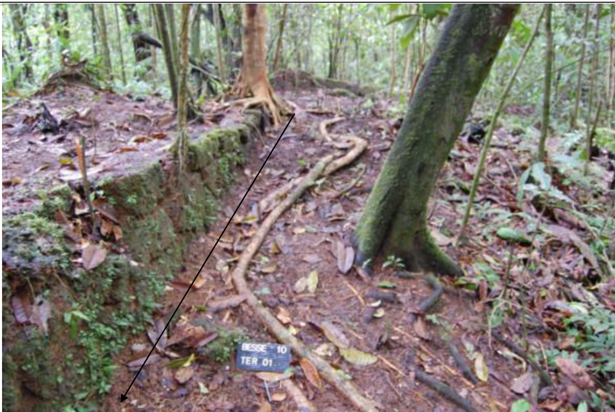
Figure 34 : vue du mur de terrasse suivant le dénivelé de la pente. 2010
