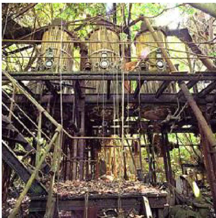
Figure 4 : Les cuiseurs sous-vide de la sucrerie du Rorota. Cliché M. Heller, DRAC Guyane, service de l'inventaire, 2001.
