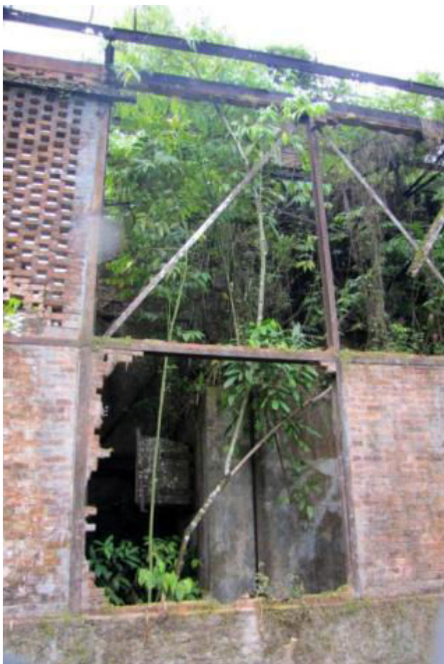
Figure 10 : Façade Ouest de la distillerie. Rapport Architecte
