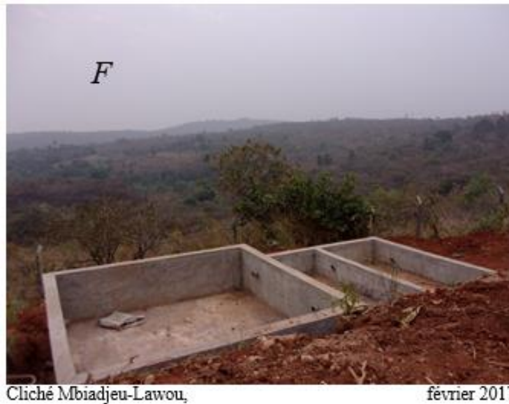
Photo 5: Les casiers en construction
