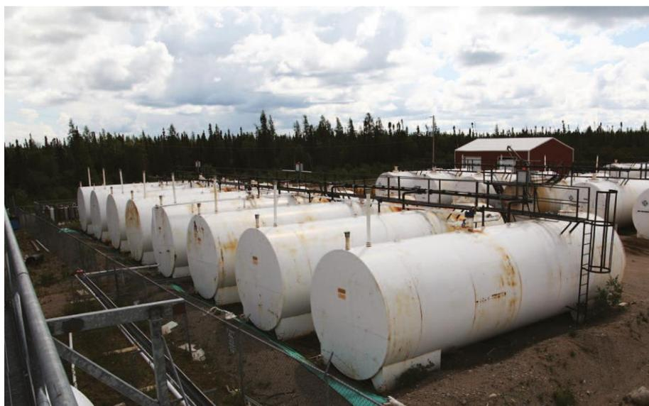
*Figure 2- Vieux réservoirs de Stockage du carburant et avec une capacité de stockage insuffisante dans un site éloigné au Canada [11]*
