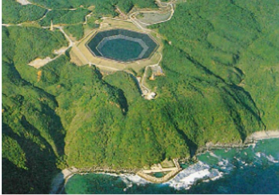
*Figure 25 – Pompage- turbinage de l'eau de mer à Okinawa au Japon (Capacité 30 MW) [57]*
