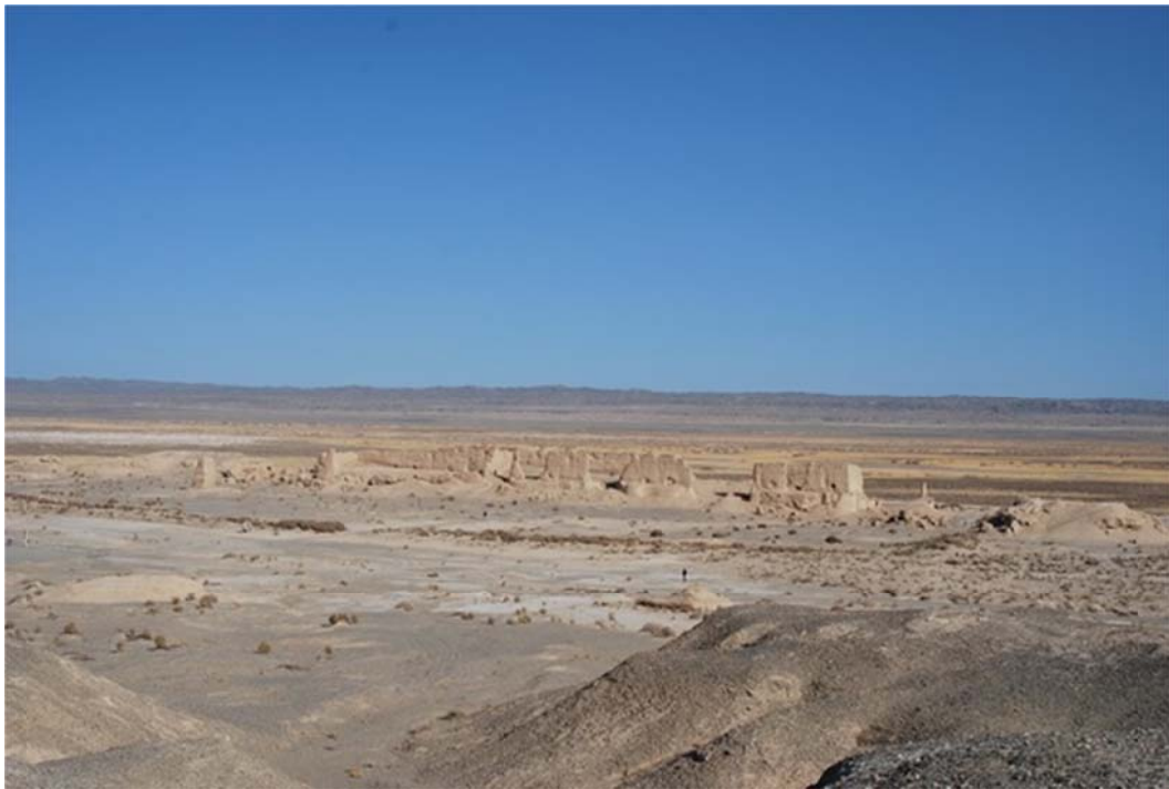
Figure 24 : Dafangpan, vue plongeante depuis la tour D32 (T18), au sud-ouest (©Arnaud Bertrand, 2014)
