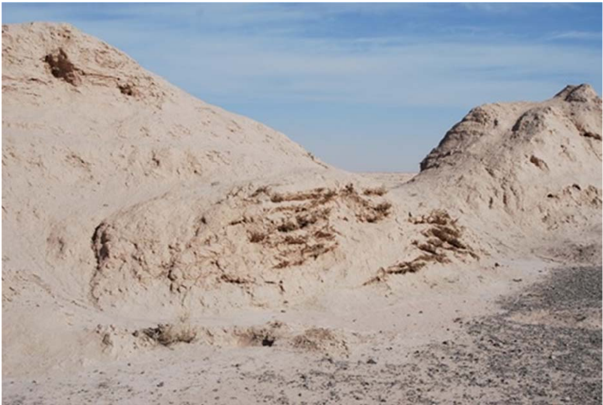
Figure 62 : Rempart nord, avec son appareil fait d'un mélange de terre et de faisceaux de roseaux (©Arnaud Bertrand, 2014)
