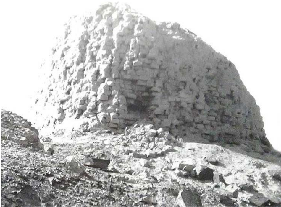
Figure 228 : Tour D90, paroi orientale (©Wu Rengxiang, 2003, photo n°87]
