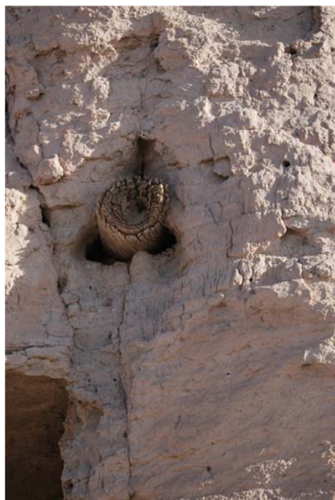
Figure 184 Madrier inséré dans le rempart nord, au-dessus de l'entrée principale (c) Arnaud Bertrand
