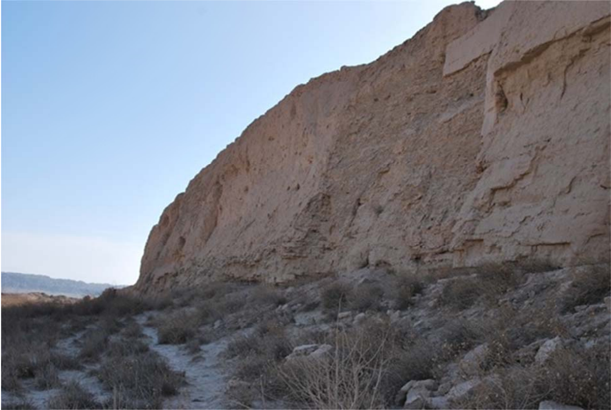
Figure 146 : Rempart surélevé par une plateforme en terre damnée (©Arnaud Bertrand, 2014)
