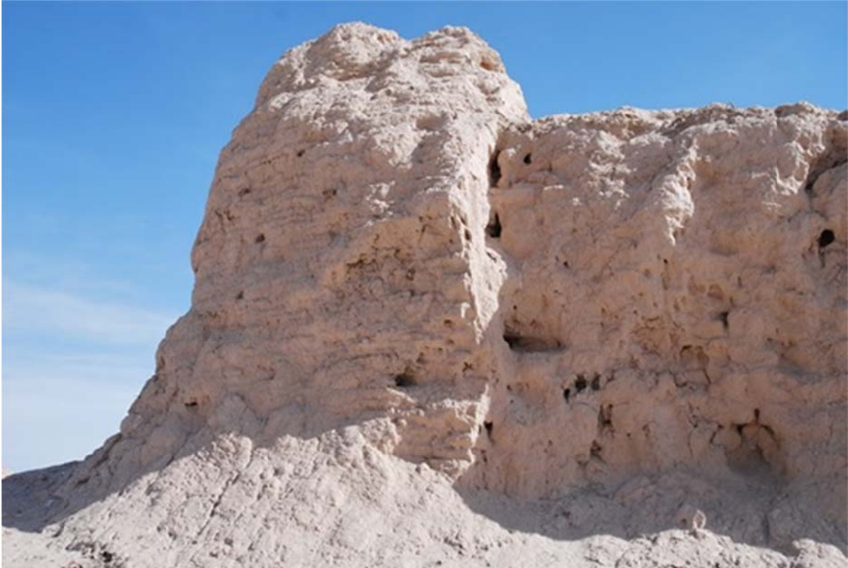
Figure 63 : Tour d'angle nord-est, vue depuis l'intérieur du site (©Arnaud Bertrand, 2014)
