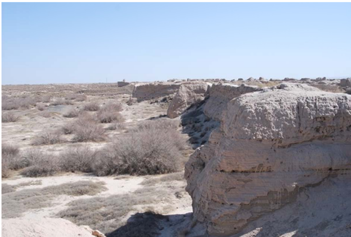
Figure 77 : Mamian du rempart sud de la ville interne (©Arnaud Bertrand, 2014)
