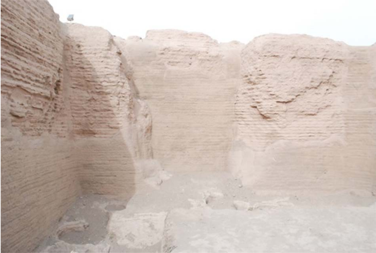
Figure 84 : Fort B, vue depuis le bord-ouest (façade intérieure) (©Arnaud Bertrand, 2014)
