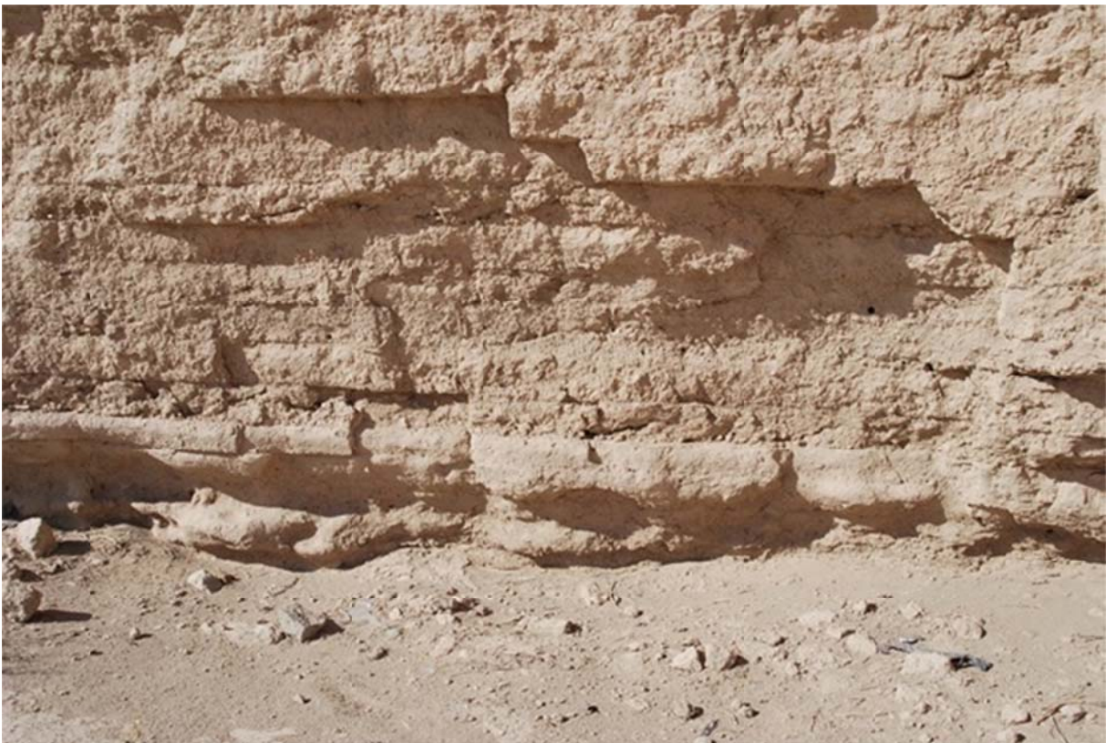
Figure 147 : Mur de soutènement (©Arnaud Bertrand, 2014)
