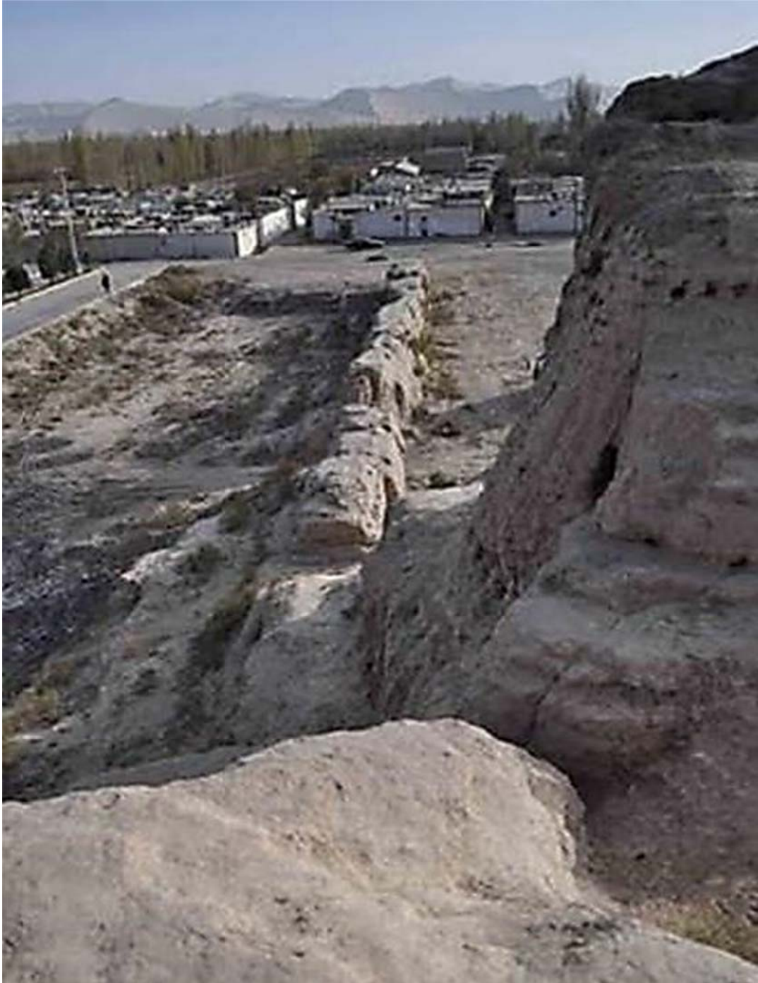
Figure 198 : Rempart occidental, vue depuis la tour nord-ouest (©Arnaud Bertrand, 2014)
