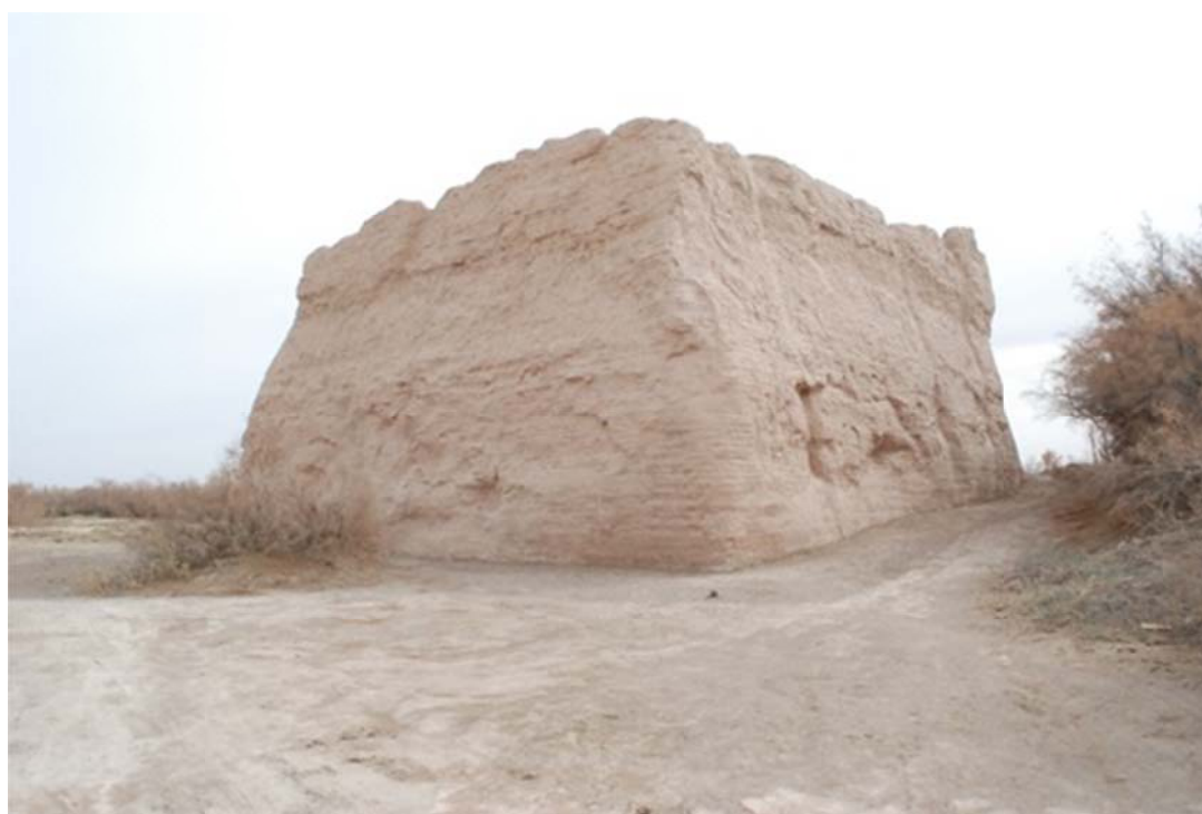
Figure 83 : Fort B, vue depuis le sud-est (façade extérieure) (©Arnaud Bertrand, 2014)
