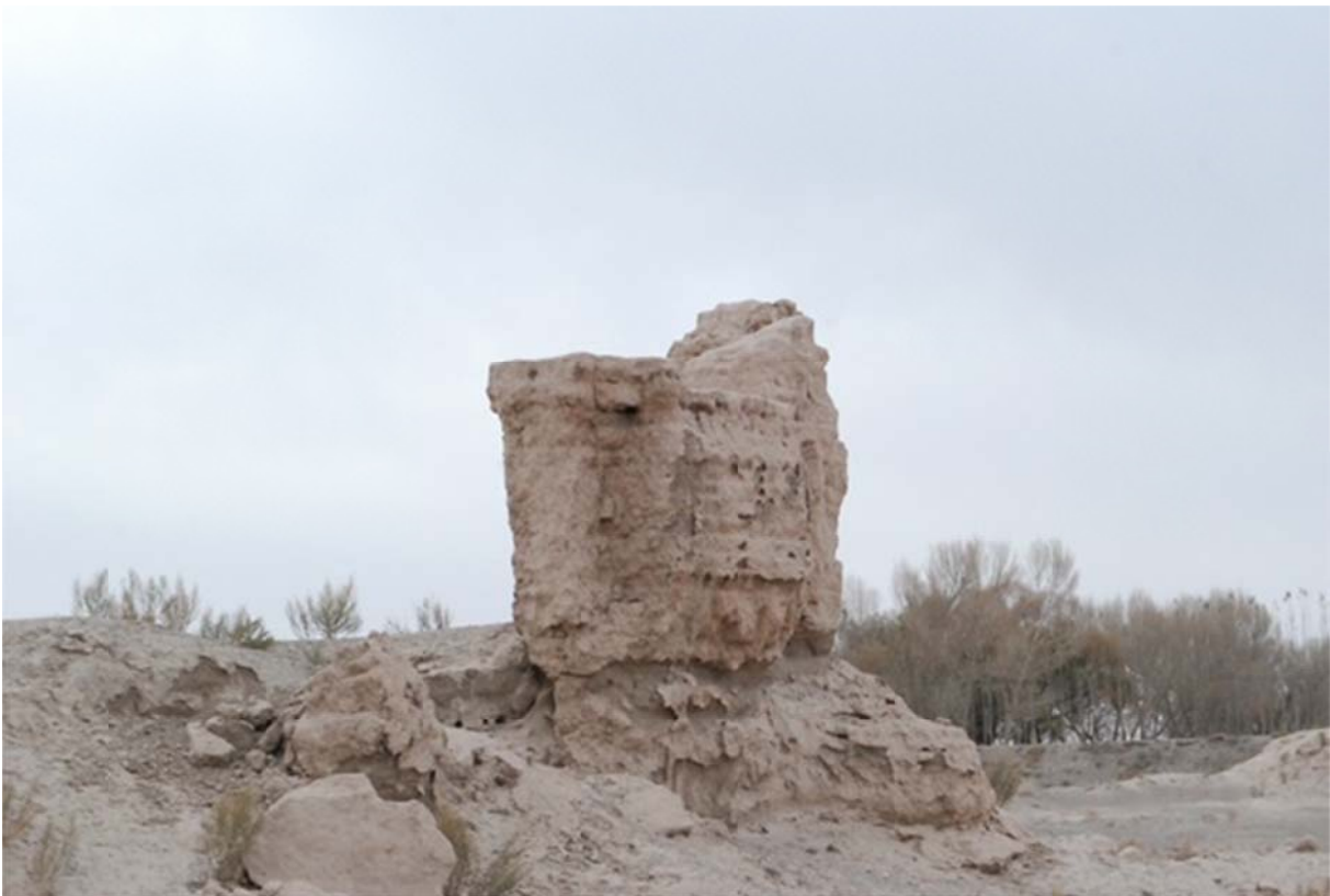
Figure 113 : Tour sud-ouest du second bâtiment fortifié, vue depuis le nord-ouest (©Arnaud Bertrand, 2014)
