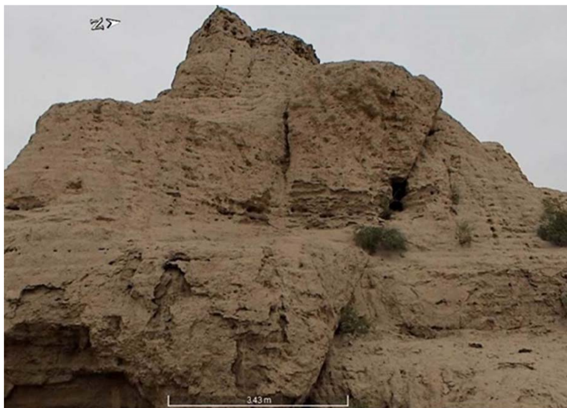
Figure 199 (Tour d'angle nord-ouest raccordée au bloc massif du rempart occidental (©Google Earth, 2016)
