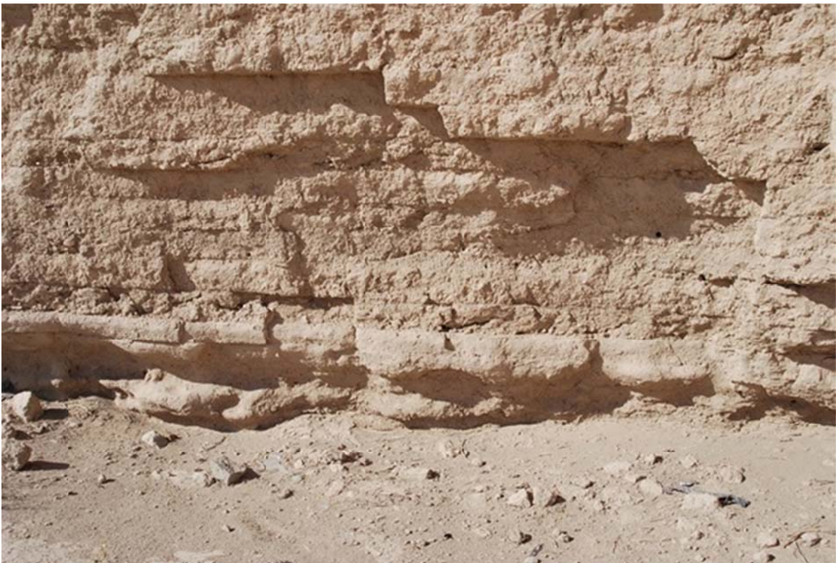
Figure 147 : Mur de soutènement (©Arnaud Bertrand, 2014)
