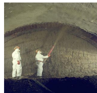
Revêtement d'un tunnel
