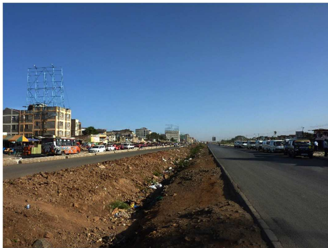
Figure 22 : La rocade Outer Ring road, marquant la séparation entre Buruburu et Umoja. Source : JBL, mars 2017.
