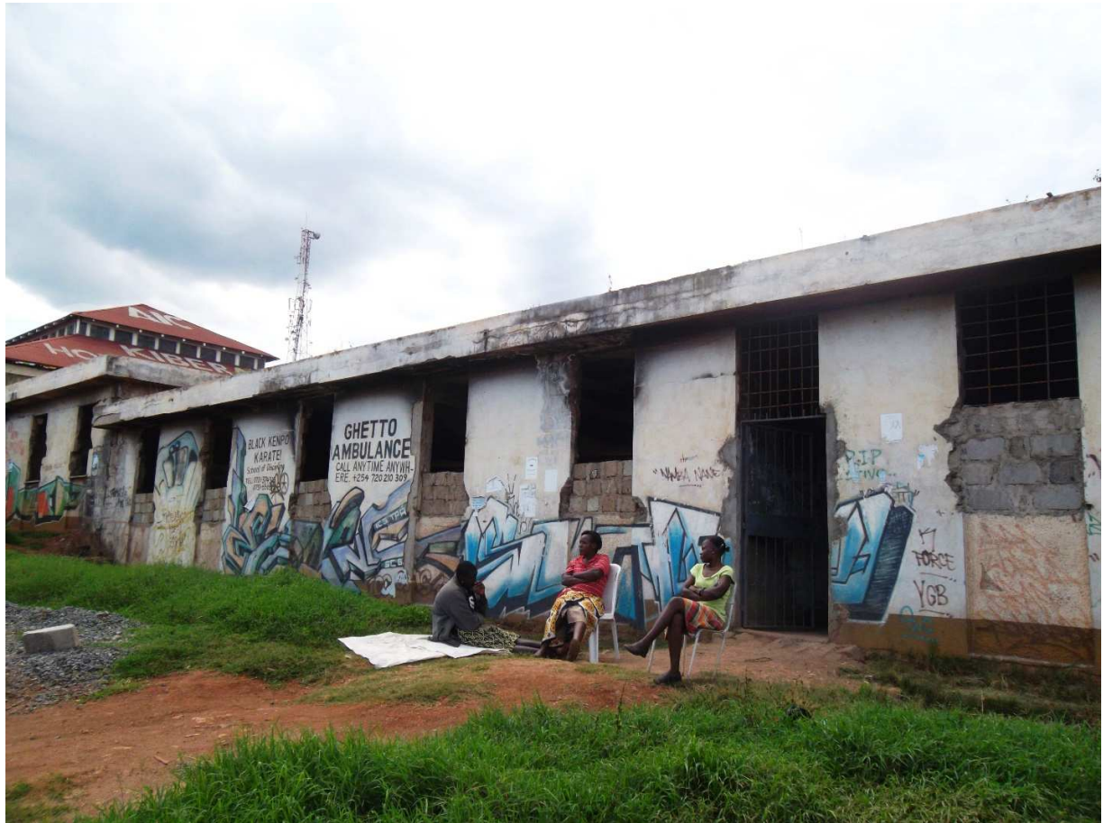
Figure 12 : Les restes d'un garage incendié dans le quartier d'Olympic, Kibera. Au premier plan, trois femmes discutent. JB Lanne, février 2012
