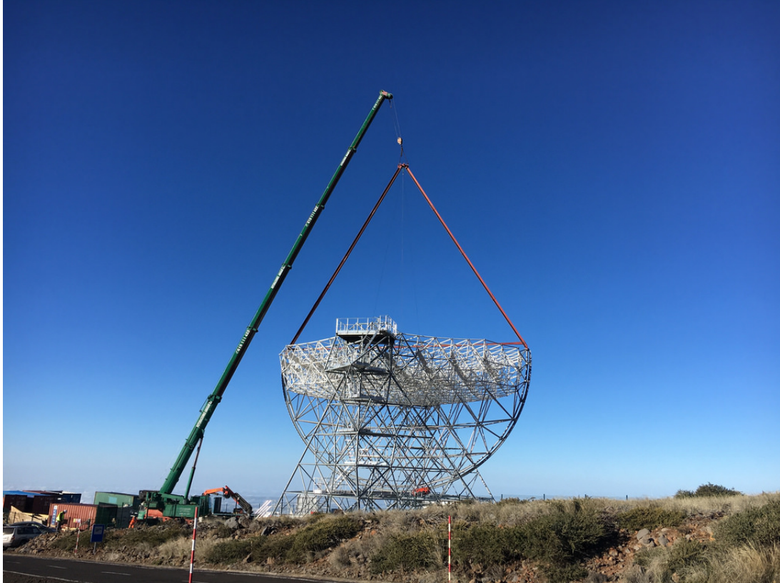
FIGURE 2.1 – Prototype de grand télescope de CTA en construction à La Palma (Espagne).
