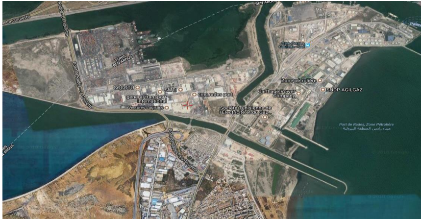
Figure 5-11 Présentation détaillée du port de Radès
