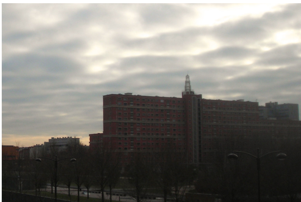
Figure 5: La cité Gagarine à Ivry-sur-Seine, 5 janvier 2010.
