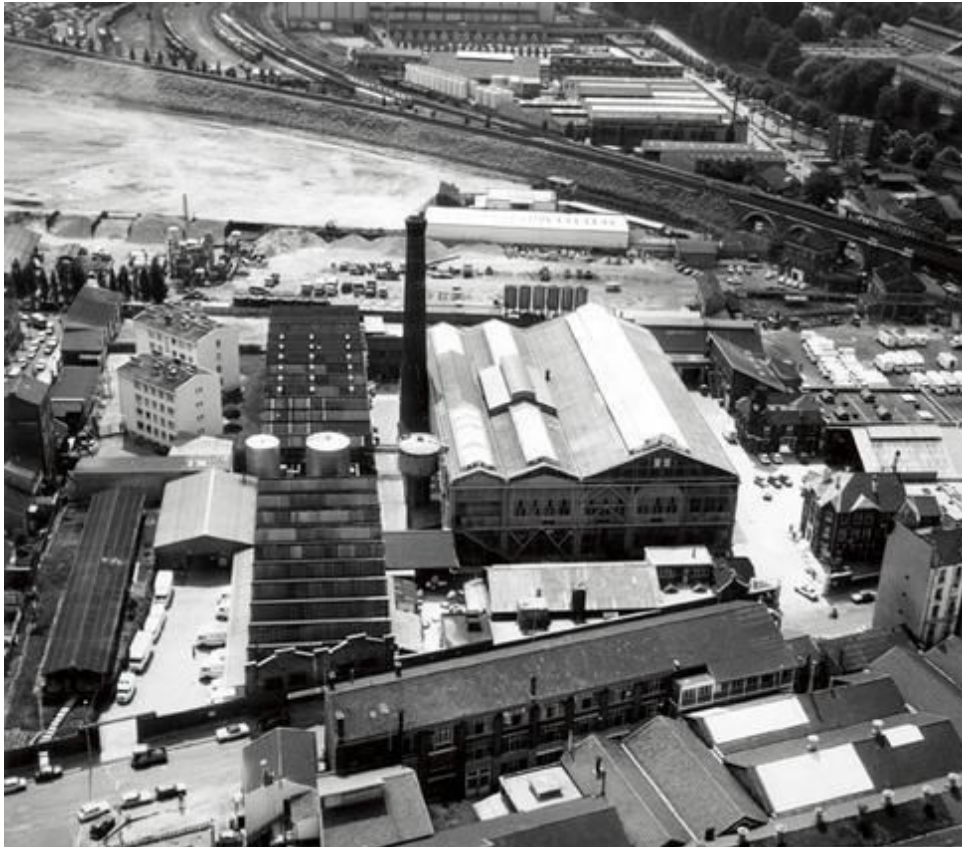
Figure 1: Usines à Issy-les-Moulineaux, photo aérienne, 1974. Photo Jean Bruchet. Source: Photothèque IAU îdF. © IAU îdF.
