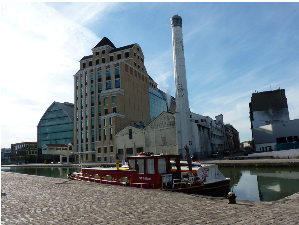
Figure 15: Les Grands Moulins de Pantin rénovés par Reichen & Roberts au bord du canal de l'Ourcq, 27 juillet 2010.
