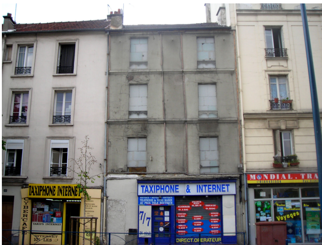
Figure 12 : Immeuble vacant et commerces destinés à la population immigrée, quartier des Quatre Chemins (avenue Edouard Vaillant). 21 octobre 2012.
