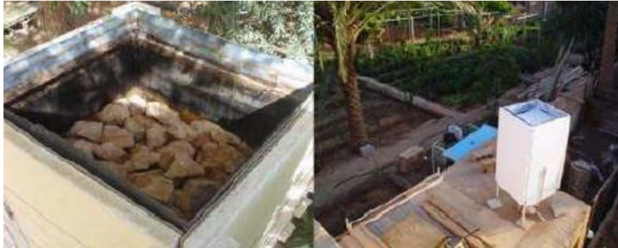
Figure I.5. Toiture réfléchive-éaporative [Ben Cheikh et Bouchair, 2008]
