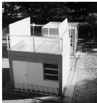
Figure I.4. Cellule test avec un toit protégé [Rincón et al, 2000]
