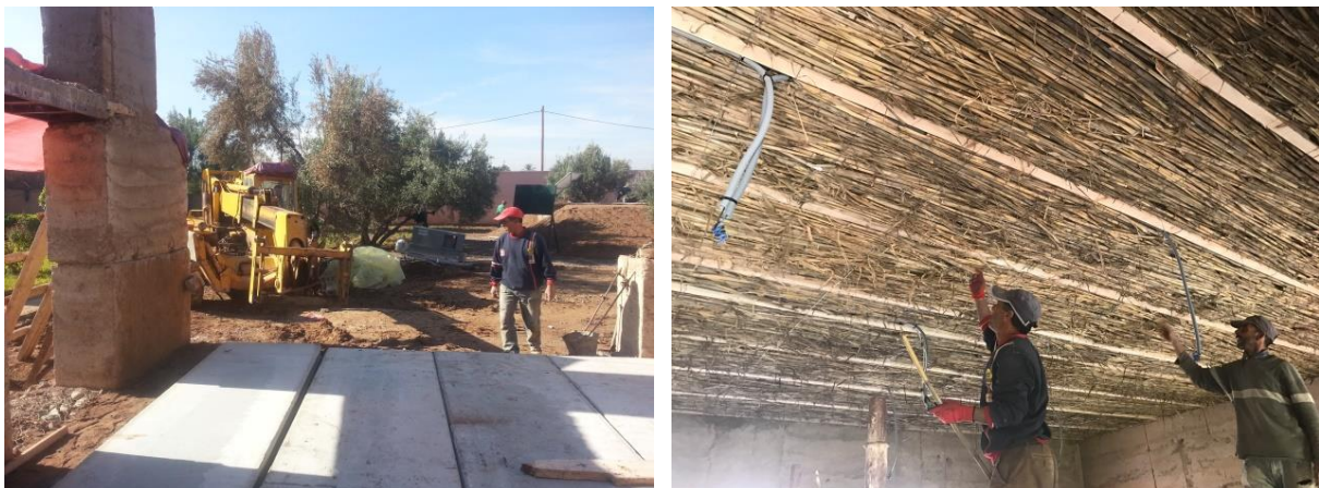
Figure II.10. La mise en œuvre du plancher bas (photo de gauche) et l'isolation du toit par des roseaux (photo de droite).
